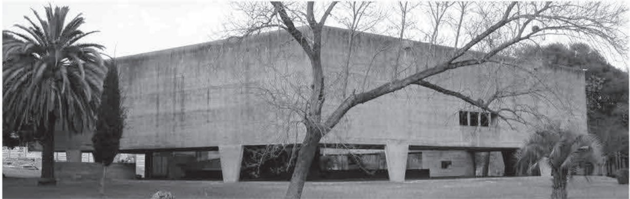
Figura 1: Vista de las fachadas norte y este del edificio.
