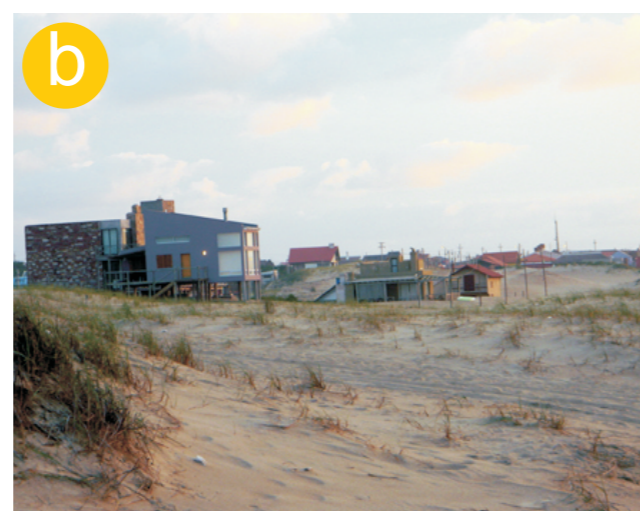
construcción sobre dunas
