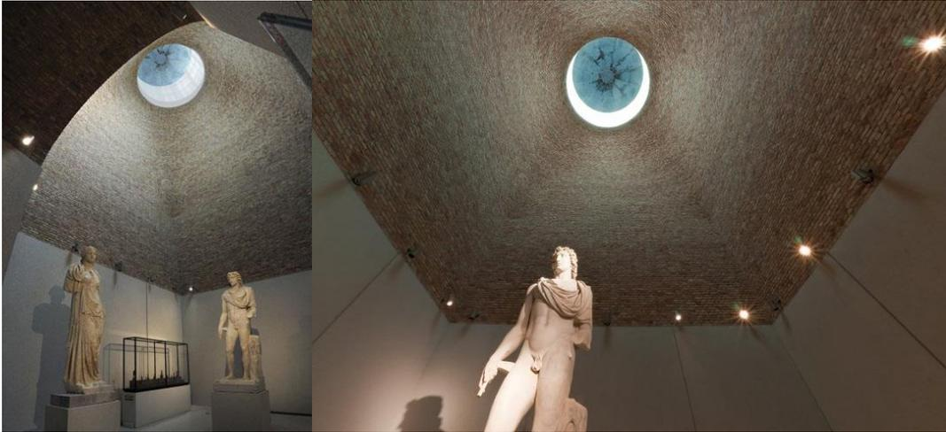
Cabe destacar la innovación de Chipperfield a la hora de trabajar la cúpula, logrando pasar de una base de sección cuadrada, a una circular en el extremo lindero con el óculo, dicho pasaje se da de una manera gradual y bien distante de cómo se materializó en épocas anteriores.
