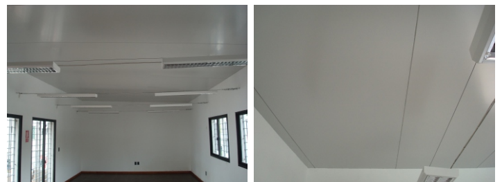
-Techo de Isopaneles.
