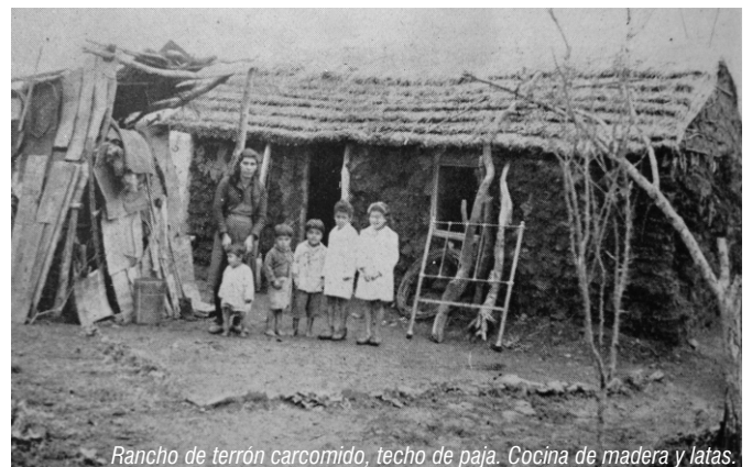
Rancho de terrón carcomido, techo de paja. Cocina de madera y latas.
