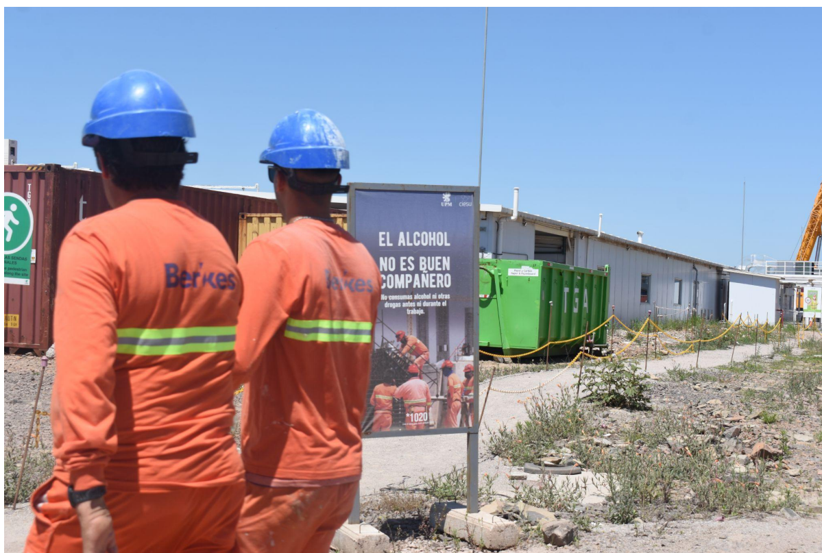
Cartelería en planta UPM II en construcción, noviembre 2022.
