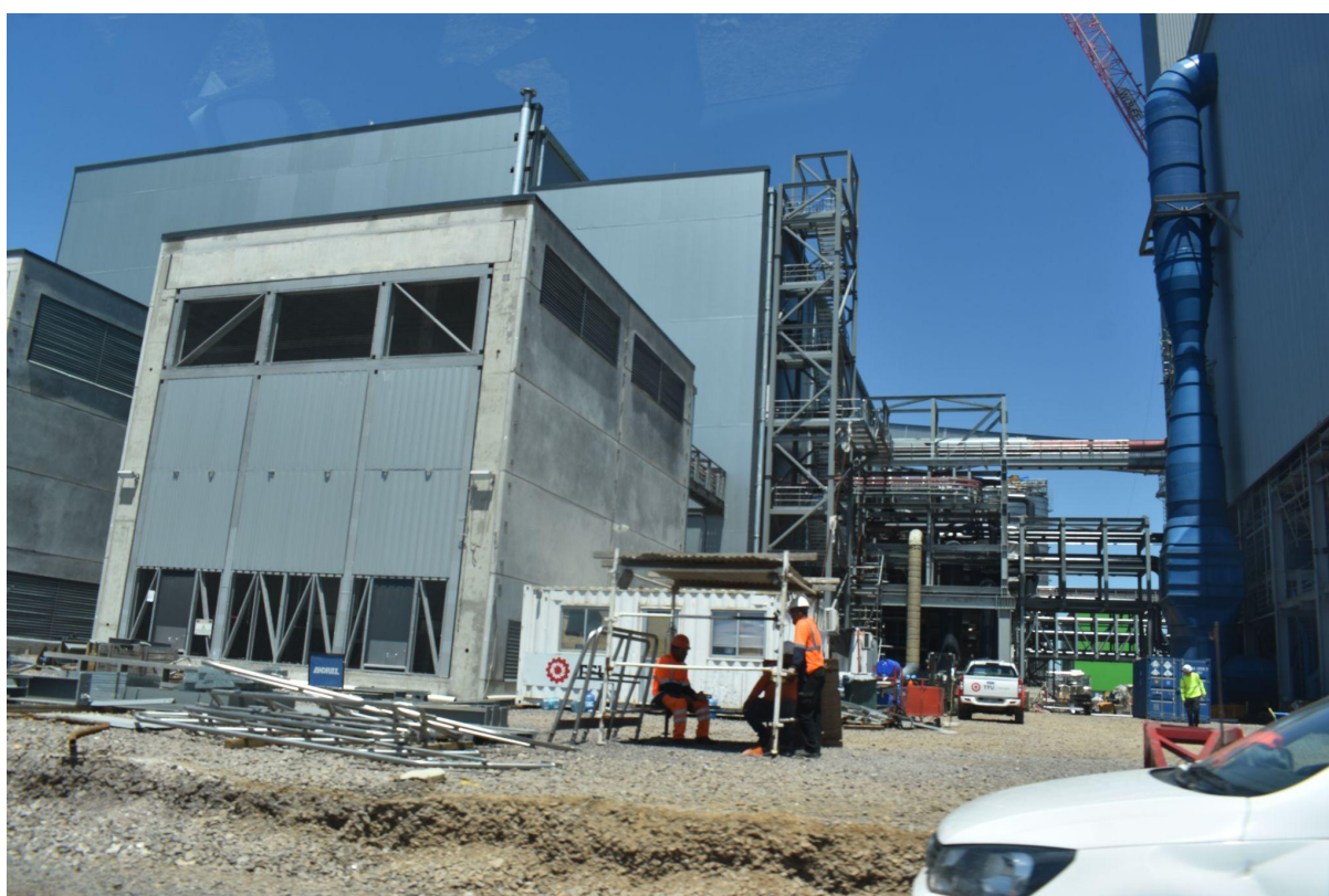
Planta de UPM II en construcción, 2022.
