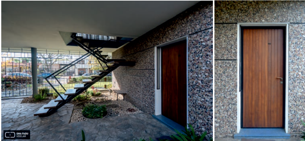
Fotografías de acceso a la Unidad 001. Se insinúa en el umbral el singular pavimento que nos acompañará en el resto de la vivienda. Así mismo el revestimiento de piedra ahogada en la superficie de la fachada, que luego encontraremos del lado interior. Vease el detalle de la luminaria empotrada en un nicho generado en la mocheta a la izquierda de la puerta.
