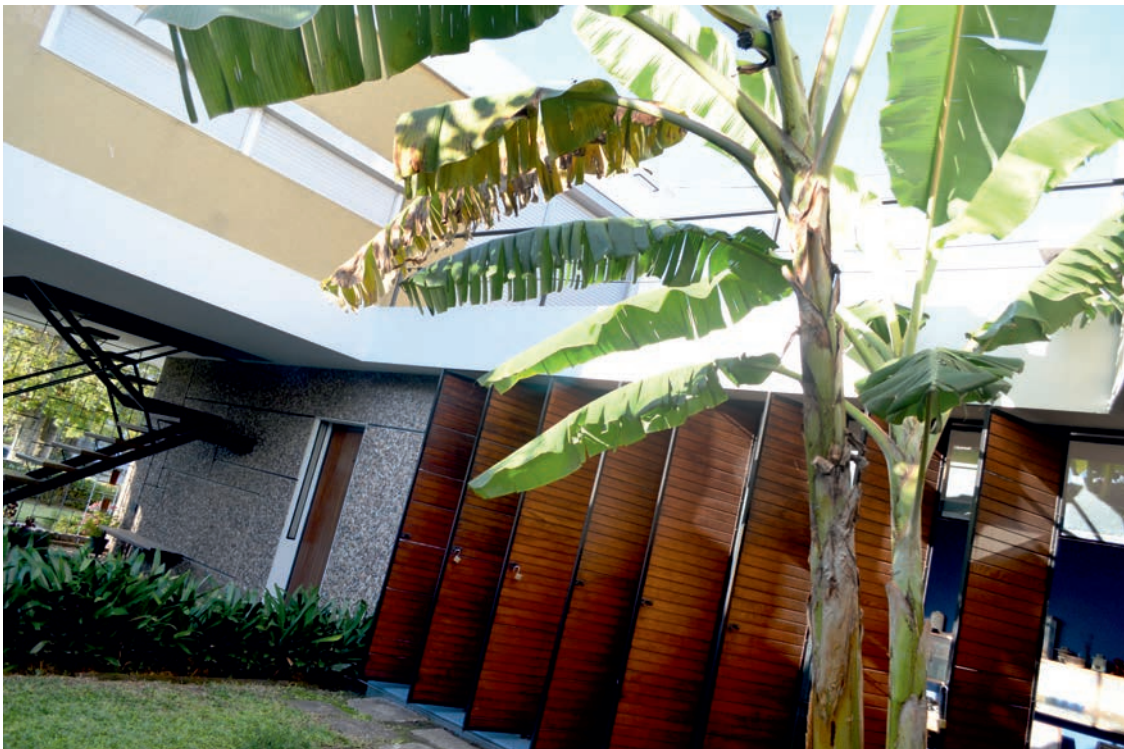
Fotografía desde el patio interno. Los parasoles de la Unidad 001 se encuentran abiertos en posición perpendicular a la fachada, permitiendo la entrada de luz y sol a la planta baja de dicha unidad.
