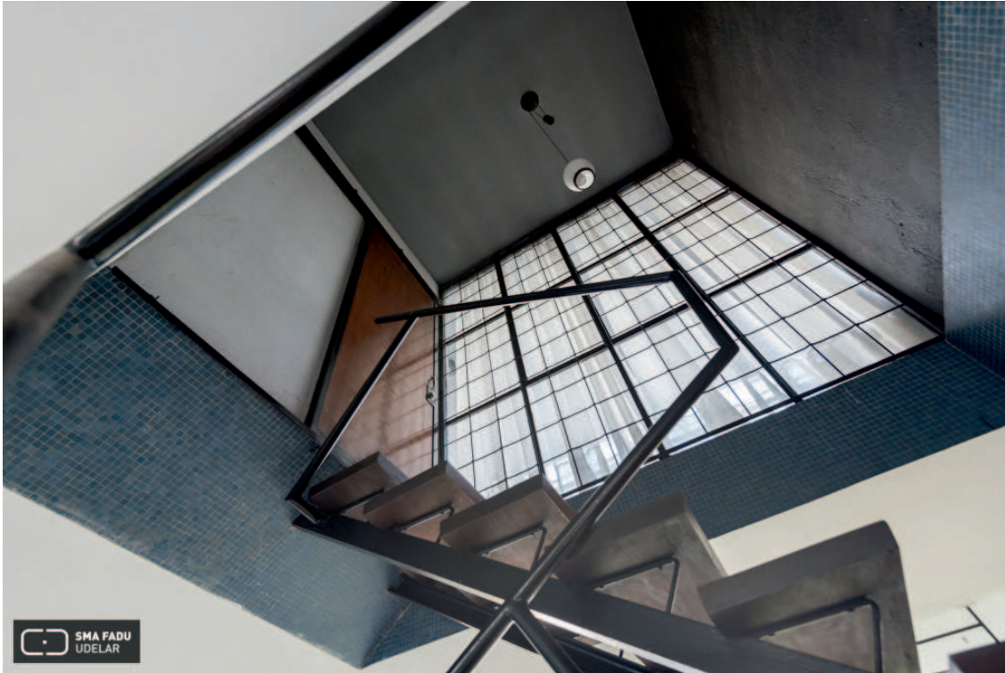
Fotografía de culminación de escalera que nos sitúa en la puerta de acceso a la Unidad 002. Se nos presenta la materialidad que luego encontraremos dentro del loft: hierro, madera y el pavimento azul de las venecitas.
