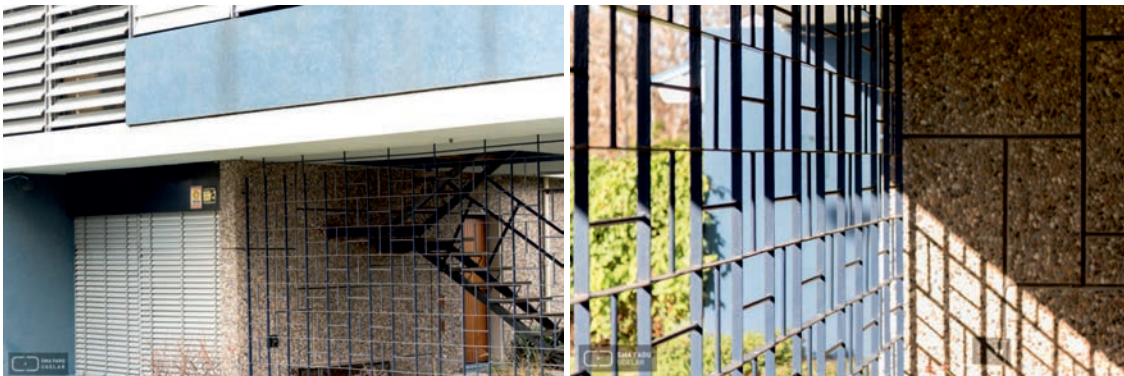
Fotografía exterior del volumen del consultorio. Se observa detalle del plano de revestimiento de fachada con la terminación en piedra ahogada.
