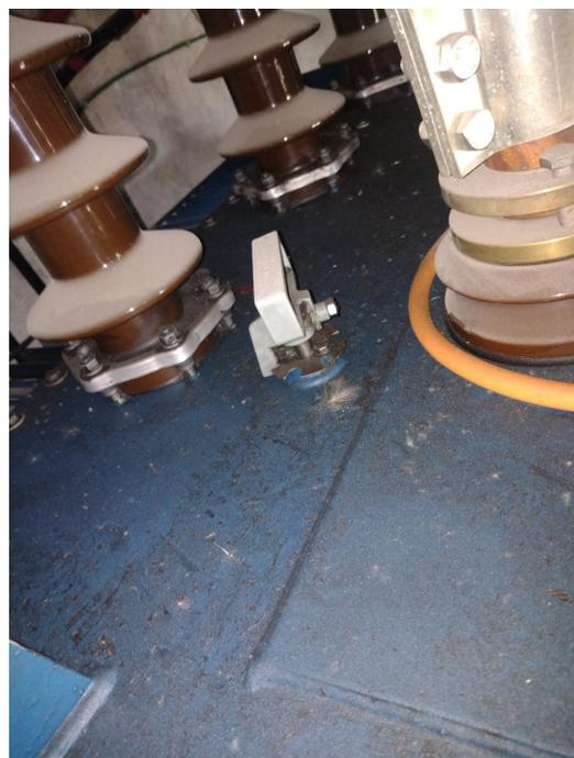
Figura 6.4: Cambiador de tomas del transformador T3 Cristalpet
