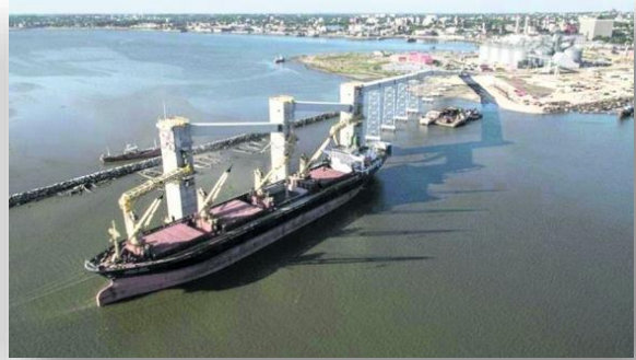
Figura 2. Muelle de carga de la terminal de granos de Montevideo.
