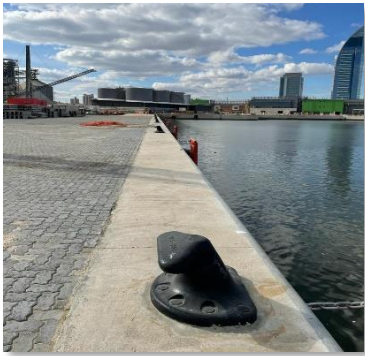
Figura 9. Nuevo muelle en construcción.
