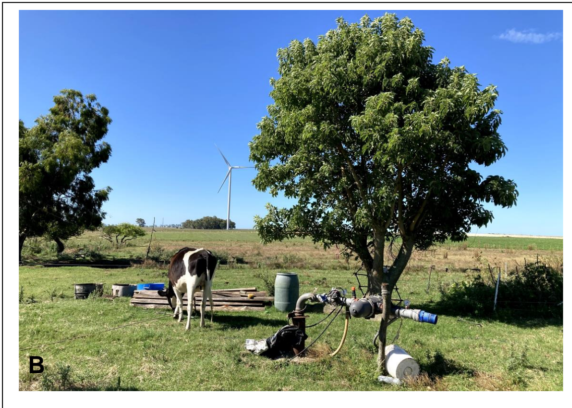
Figura 17: A: Pozo 6b de tipo brocal. B: Pozo 47a de tipo semisurgente.
