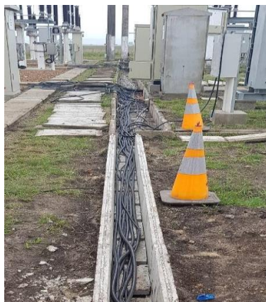
Imagen 3 - Canalizaciones en obra entre los equipos de maniobra y el edificio de control
