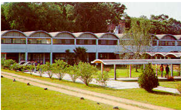
Fig. 6- Vista de las instalaciones de la Estación Experimental de SUL, Florida.
