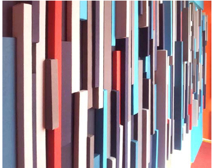
Figura 1.11. Difusor MLS fabricado en madera. © Interaudiigital
