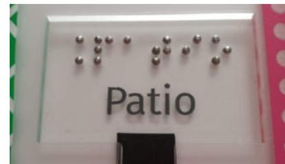
Se representan mediante calado integrados a los espacios de circulación. Se los numera como patio 1, 2 y 3. Los espacios se identifican a través del nombre generados en caracteres visuales por grabado y pintado, y en braille por incrustación de esferas sobre la superficie de la base del plano.
