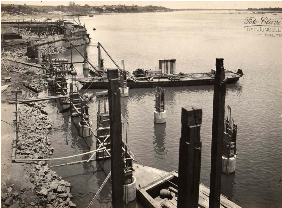
Figura 11. Construcción del muelle de cemento del Puerto de Salto (entre 1928 y 1931). Al fondo se ve barranco al sur de la ciudad de Salto. Foto Clavé
