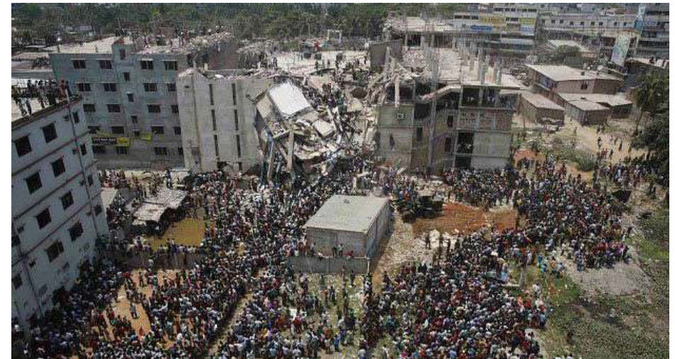
Las ruinas del complejo Rana Plaza después de su colapso en las afueras de Dhaka, capital de Bangladesh, Biraj, A. (2018)
