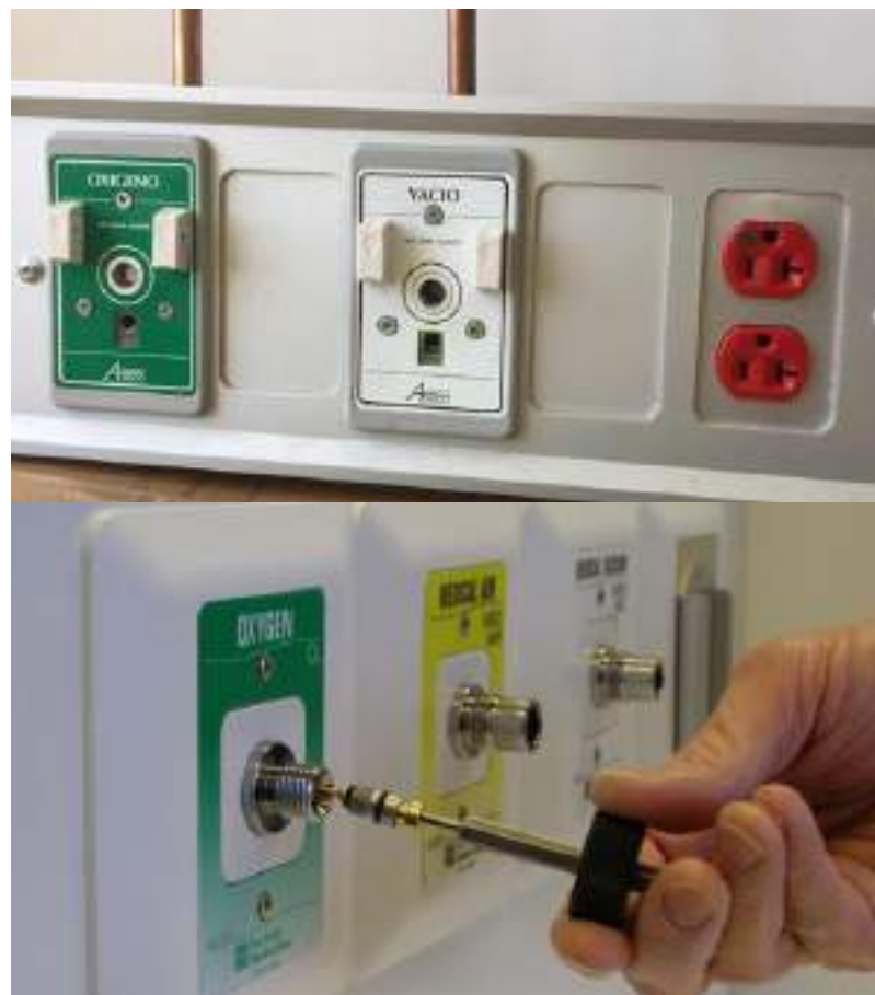
Ejemplos de entradas para conectar mangueras y extraer gases tales como oxígeno de un sistema de canalización.
