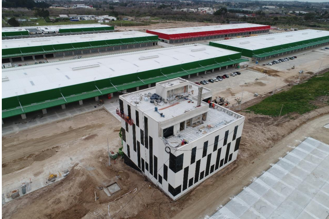
Fig. 5b. Proceso de obra edificio Centro Administrativo. Vista desde noreste. Fuente: Recaudos proporcionados por UAM - CA
