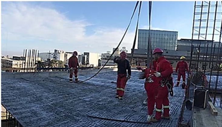
Ilustración 178. Anexo Torre Ejecutiva | Trabajos en altura. Elementos de protección personal. Fotografía gentileza Arq. Javier Olascoaga.
