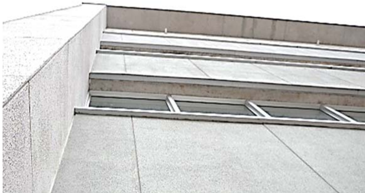
Ilustración 159. Centro Parque Batlle | Sistema de cierre en placas cementicias: organización, buñas. Fotografía de autor.
