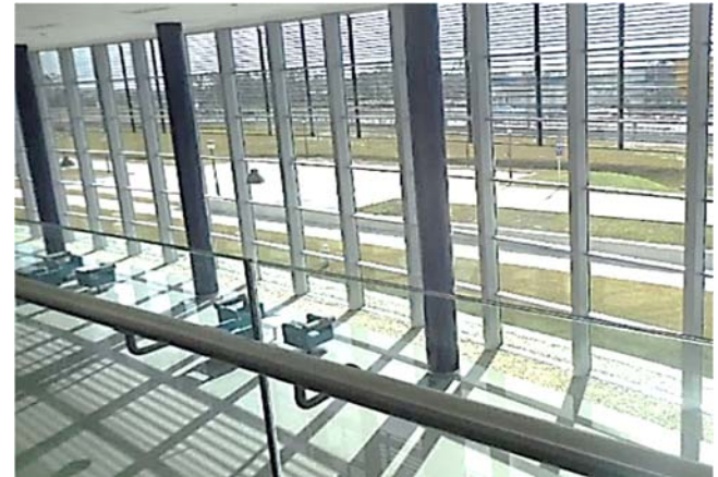
Ilustración 102. Data Center | Envoltente Fotografías de autor y gentileza Arq. Carina Curbelo
