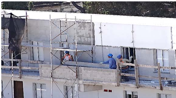
Ilustración 181. Covicordón I Confección de sistema de fachada desde las terrazas con apoyo de andamios tubulares. Fotografía gentileza Unidad Permanente de Vivienda.
