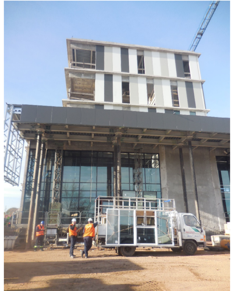
Ilustración 120. Sanatorio Banco de Seguros del Estado | Estructura metálica acceso - Testero volumen internación. Fotografía de autor.
