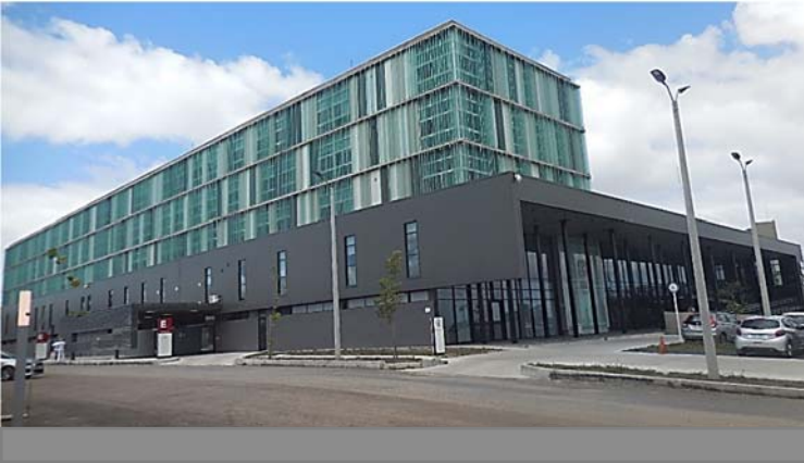
Ilustración 12. Sanatorio Banco de Seguros del Estado | Envoltente: paneles PIR, aberturas de aluminio y parasoles. Fotografía de autor.
