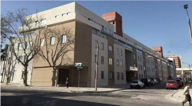
Ilustración 90. Covicordón I Fachadas norte y este. Terminación pintura texturada. Fotografía gentileza Instituto de Asistencia Técnica CEDAS.
