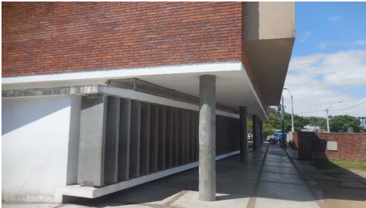
Ilustración 116. Escuela 296 Pando Sur I Sistema de parasoles fijos de hormigón armado en fachada cocina. Fotografía de autor.
