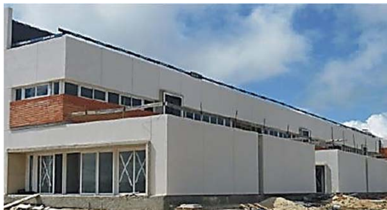
Ilustración 201. Instituto de Producción Animal | Fachada a la ruta. Cerramientos macizos pesados de hormigón armado. Fotografía gentileza Arq. Daniel Calzada.
