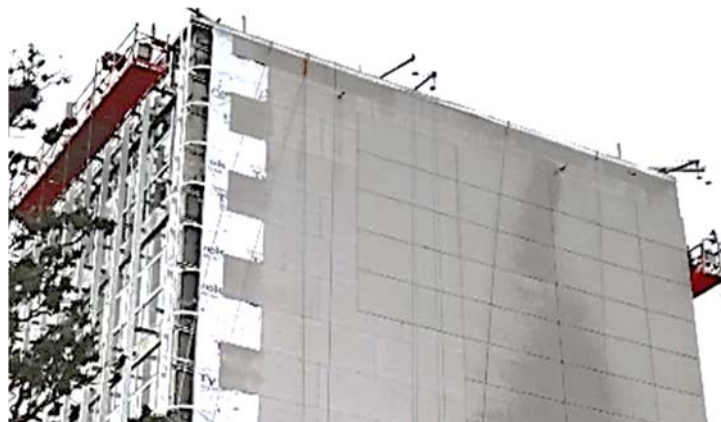
Ilustración 174. Centro Parque Batlle. Trabajos en altura mediante balancines: previsiones desde la cubierta. Fotografía de autor.
