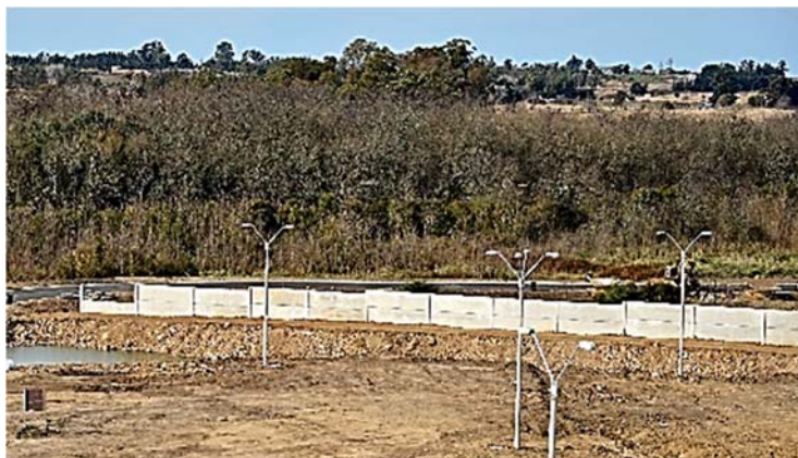
Ilustración 212. Data Center I Muro perimetral de hormigón armado que resguarda al edificio del entorno. Fotografía gentileza Arq. Carlos Rodríguez.
