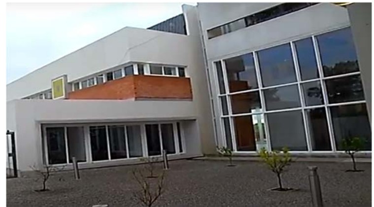
Ilustración 124. Instituto de Producción Animal | Terminación continua de envoltente con revoque predefinido. Fotografía gentileza Arq. Daniel Calzada.
