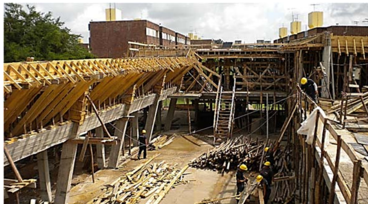
Ilustración 185. Escuela 296 Pando Sur I Trabajos de encofrado tradicional: viga canalón de apoyo de cubierta metálica. Fotografía gentileza PAEPU.
