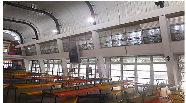
Ilustración 117. Escuela 296 Pando Sur | Espacio central: cubierta metálica con cerramientos verticales vidriados. Fotografía de autor.
