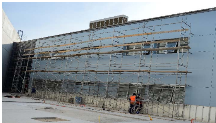
Ilustración 184. Data Center I Edificio de clientes. Trabajos en fachadas interiores con apoyo de andamios tubulares. Fotografía gentileza Arq. Carlos Rodríguez.
