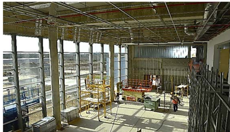
Ilustración 274. Data Center I Edificio de clientes: curtain wall independiente de instalaciones. Fotografía gentileza Arq. Carina Curbelo.
