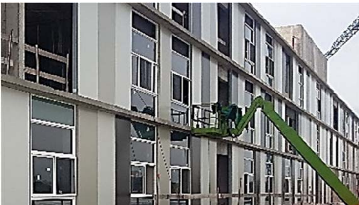
Ilustración 172. Sanatorio Banco de Seguros del Estado | Envoltorio - Sellado exterior dispositivos móviles. Fotografía de autor.
