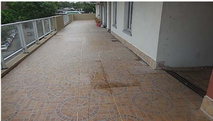
Ilustración 306. Covicordón I Terraza con pendiente hacia reguera en plomo de fachada. Fotografía de autor.
