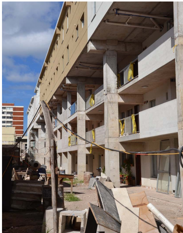
Ilustración 272. Covicordón Fachada interior en etapa de materialización. Fotografía gentileza Unidad Permanente de Vivienda.
