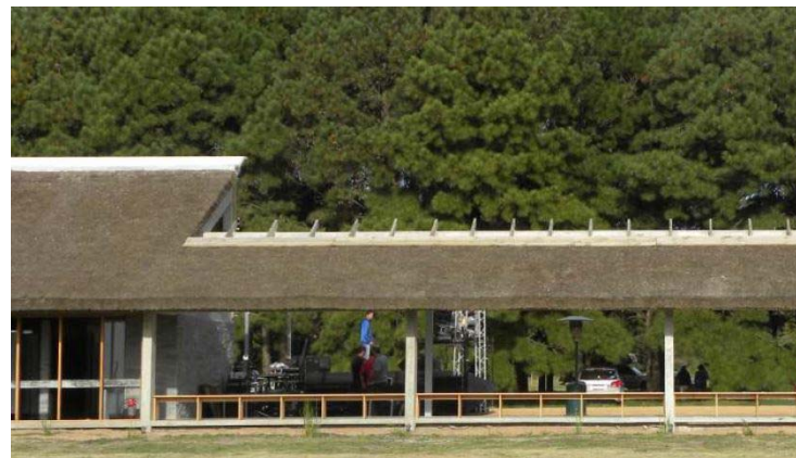
Ilustración 226. Portal del Polonio | Cubierta: espacios cerrados y semicalados. Bosque de pinos por detrás. Fotografía gentileza Arq. Federico Gastambide.
