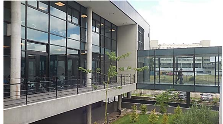
Ilustración 13. Sanatorio Banco de Seguros del Estado | Fachada Interior. Curtain wall por detrás de estructura. Fotografía de autor.
