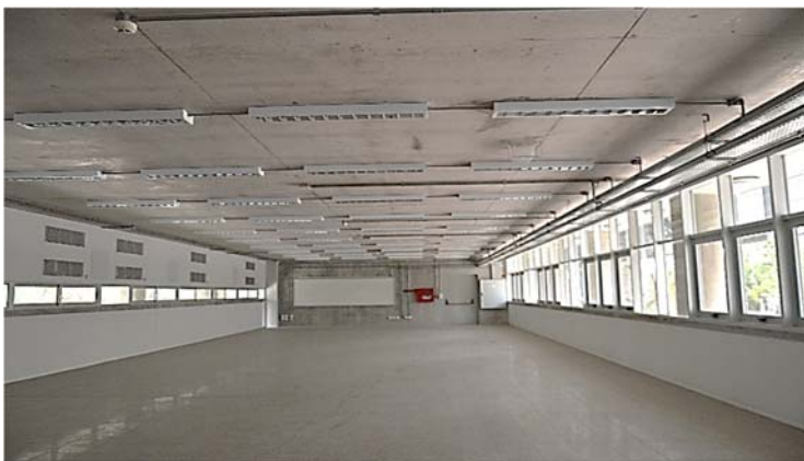
Ilustración 234. Centro Parque Batlle I | Estructura distributiva primaria a partir de plantas libres. Fotografía de autor.
