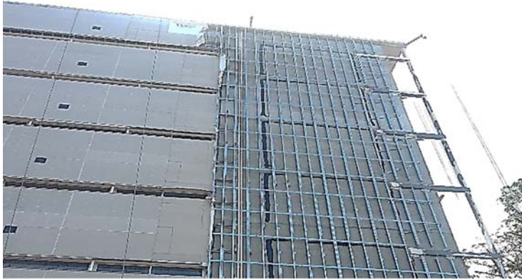
Ilustración 121. Centro Parque Batlle | Estructura liviana de sujeción para cierre con placa cementicia. Fotografía de autor.
