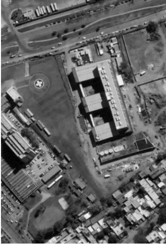
Ilustración 2. Sanatorio Banco de Seguros del Estado Fotografía extraída de Google Maps.
