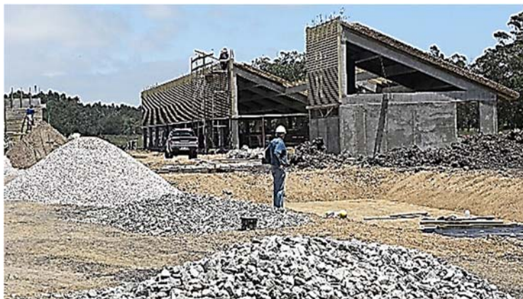
Ilustración 270. Portal del Polonio I Acopio a granel de materiales para confección de hormigón en obra. Fotografía gentileza Arq. Federico Gastambide.
