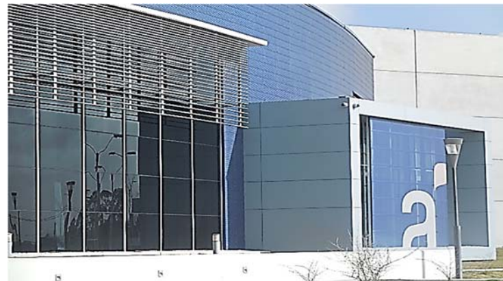
Ilustración 152. Data Center I Edificio de clientes. Concepción y materialización a partir de lógica artesanal. Fotografía de autor.
