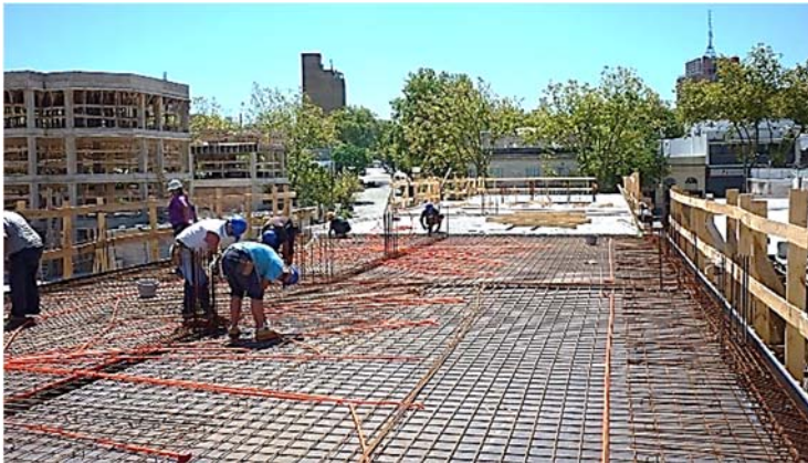
Ilustración 149. Covicordón I Sectores con estructura de hormigón armado confeccionada en sitio. Fotografía gentileza Instituto de Asistencia Técnica.
