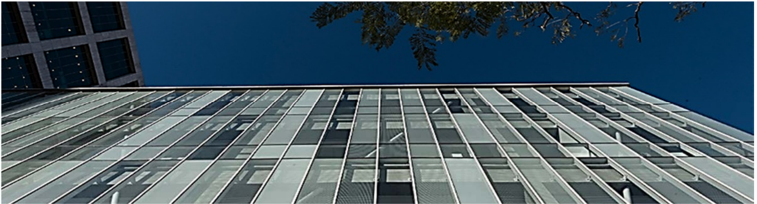
Ilustración 269. Anexo Torre Ejecutiva | Envoltiente vertical continua: sistema de termopaneles de vidrio serigrafado.. Fotografía gentileza Arq. Javier Olascoaga.
