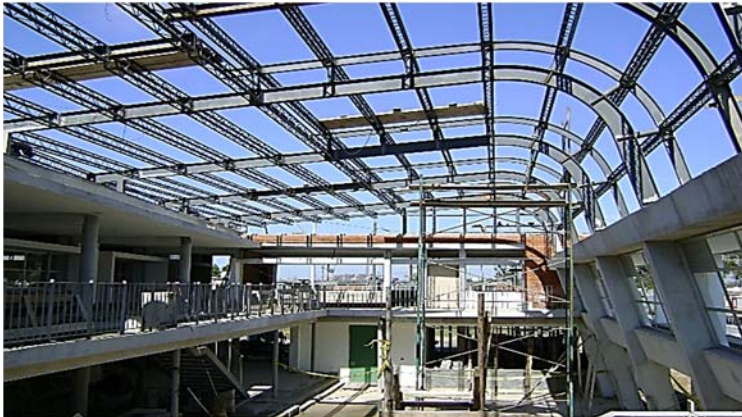
Ilustración 129. Escuela 296 Pando Sur | Estructura de la cubierta. Perfiles laminares curvados y correas reticuladas. Fotografía gentileza Arq. Virginia Gallardo.
