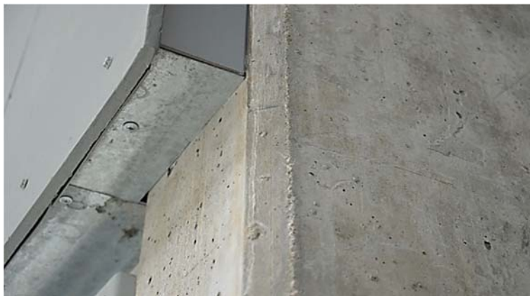
Ilustración 160. Centro Parque Batlle | Detalle estructura envolvente en acero galvanizado y pilar de hormigón armado. Fotografía de autor.
