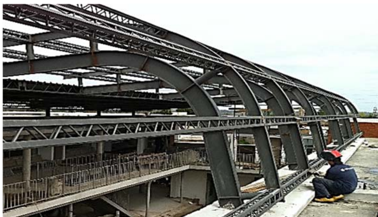
Ilustración 154. Escuela 296 Pando Sur | Estructura metálica de la cubierta. Soldado de piezas en sitio. Fotografía gentileza Arq. Virginia Gallardo.
