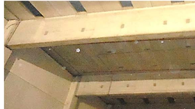
Ilustración 168. Data Center I Edificio de servicios: nave principal: sistema prefabricado de paneles y pilares. Fotografía de autor.
