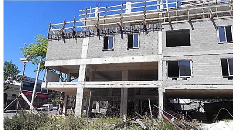
Ilustración 150. Covicordón I Estructura en hormigón armado. Cierre con mampuesto aglomerado. Fotografía gentileza Instituto de Asistencia Técnica.
