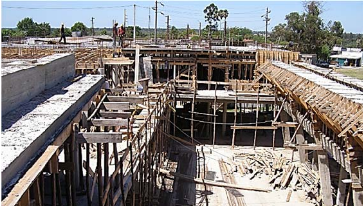
Ilustración 118. Escuela 296 Pando Sur I Sistema de encofrados tradicionales a cargo de mano de obra local. Fotografía gentileza PAEPU
