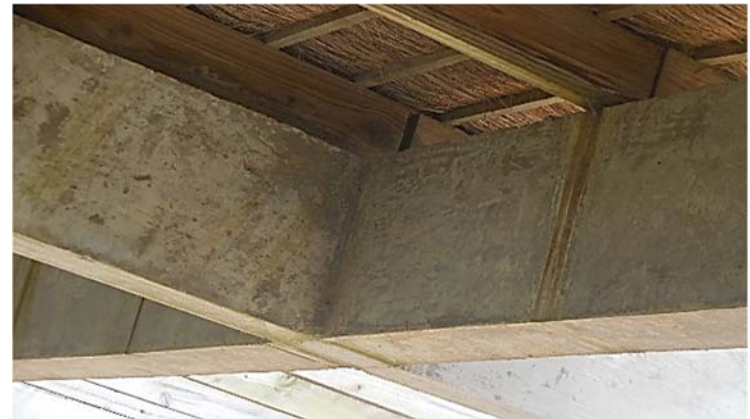
Ilustración 79. Portal del Polonio I Estructura de sostén de la cubierta de quincha inclinada Fotografía gentileza Arq. Federico Gastambide
