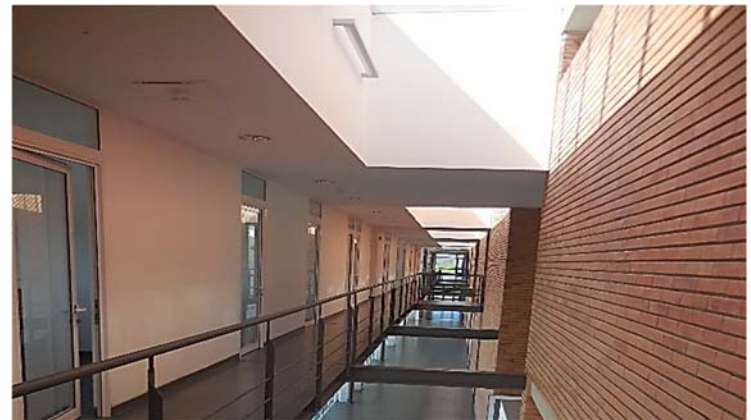
Ilustración 50. Instituto de Producción Animal | Iluminación cenital: claraboyas en circulaciones doble altura. Fotografía de autor.
