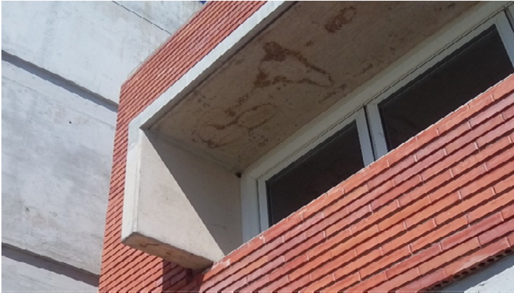
Ilustración 46. Instituto de Producción Animal | Detalle fachada norte - parasol de hormigón visto Fotografía de autor.
