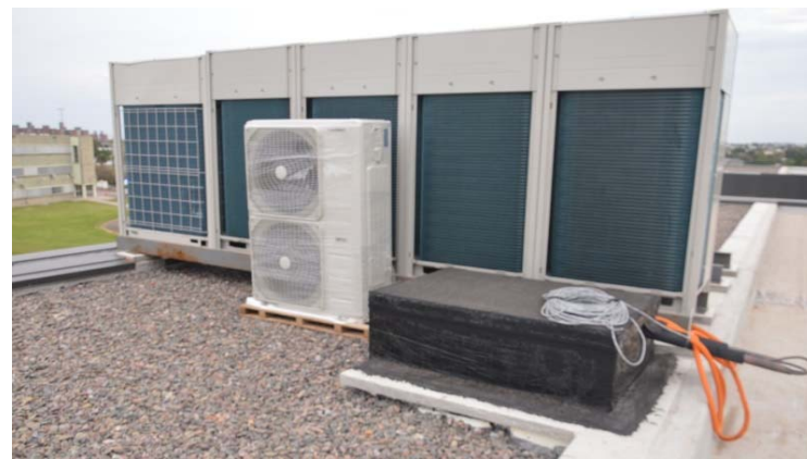
Ilustración 293. Sanatorio Banco de Seguros del Estado | Instalación de unidades exteriores de aire acondicionado. Fotografía de autor.
