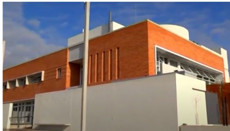
Ilustración 44. Instituto de Producción Animal I Fachada oeste. Fotografía de autor.
