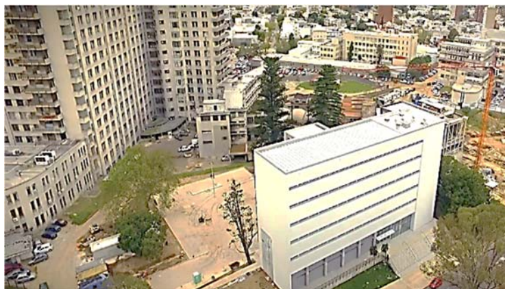
Ilustración 192. Centro Parque Batlle I Relevamiento relación física entre el Hospital de Clínicas y el conjunto. Fotografía de Plan de Obras de la Udelar.
