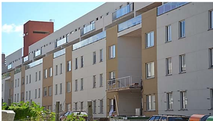
Ilustración 84. Covicordón I Fachada a calle continuación Carlos Quijano Fotografía gentileza Unidad Permanente de Vivienda
