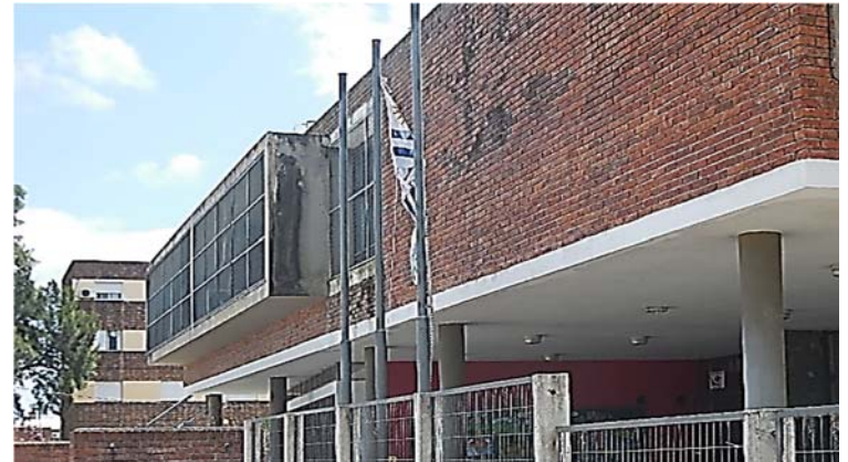
Ilustración 156. Escuela 296 Pando Sur | Primacía del ladrillo en la envolvente asociada a la fisonomía del entorno. Fotografía de autor.
