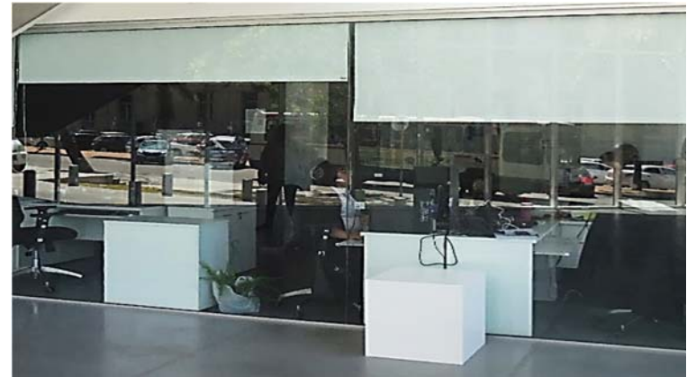
Ilustración 281. Anexo Torre Ejecutiva | Sistemas manuales tipo roller de oscurecimiento de la iluminación incidente. Fotografía de autor.
