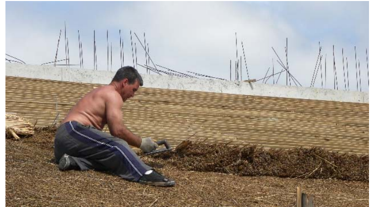
Ilustración 78. Portal del Polonio I Quinchado de la cubierta Fotografía gentileza Arq. Federico Gastambide
