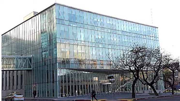
Ilustración 163. Anexo Torre Ejecutiva | Envoltente - Fachada oeste: primacía del cerramiento vidriado. Fotografía de autor.
