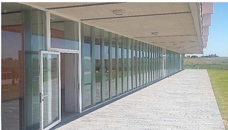
Ilustración 43. Instituto de Producción Animal I Fachada norte: galería de planta baja Fotografías gentileza Arq. Daniel Calzada
