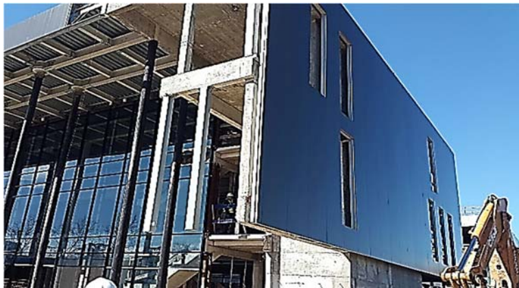
Ilustración 158. Sanatorio Banco de Seguros del Estado | Sistema industrializado. Paneles Piur multiprestaciones. Fotografía de autor.
