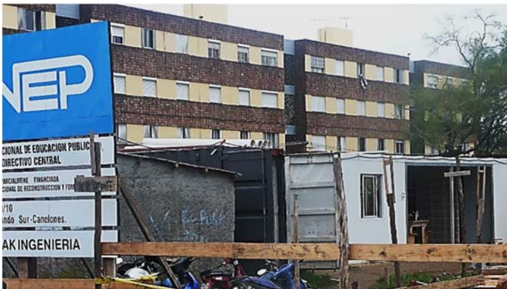
Ilustración 119. Escuela 296 Pando Sur I Organización espacial de obra. Fotografía gentileza PAEPU.
