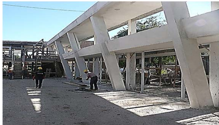
Ilustración 169. Escuela 296 Pando Sur I Canalón intermedio de construcción tradicional: recibe alero fachada este. Fotografía gentileza PAEPU.
