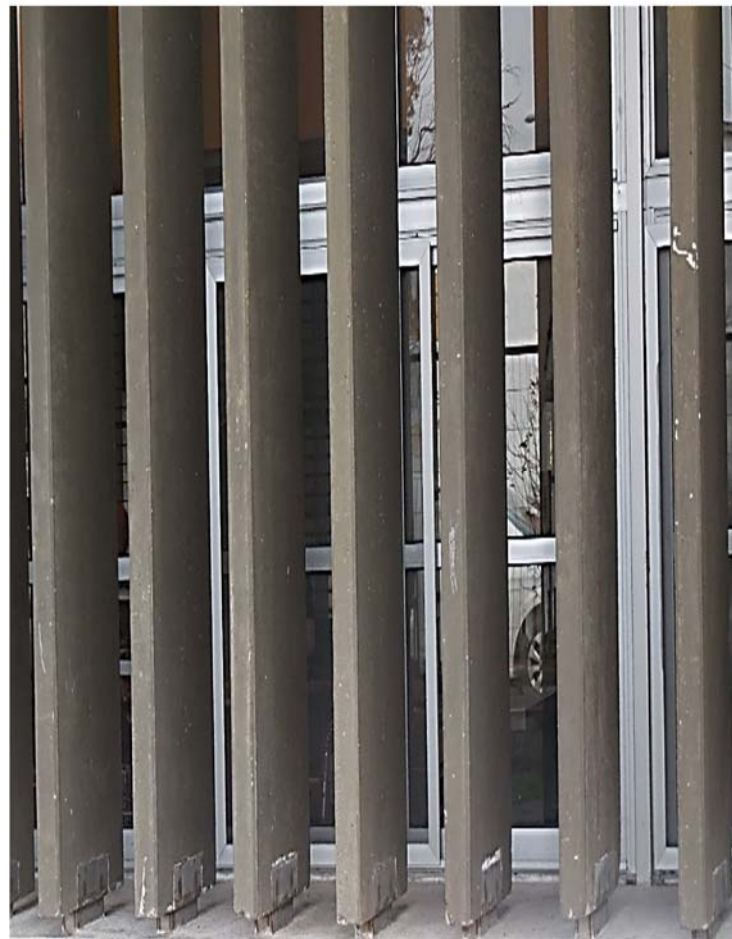
Ilustración 277. Escuela 296 Pando Sur I Parasoles de hormigón confeccionados artesanalmente pieza por pieza. Fotografía de autor.
