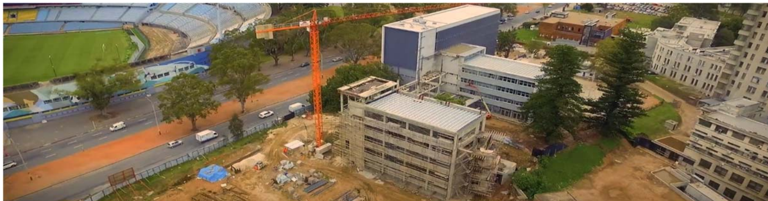
Ilustración 262. Centro Parque Batlle | Materialización del proyecto: desarrollo de la obra. Fotografía de Plan de Obras de la Udelar
