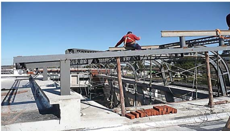
Ilustración 275. Escuela 296 Pando Sur I Armado in sitio de la estructura metálica de la cubierta curva. Fotografía gentileza Arq. Virginia Gallardo.
