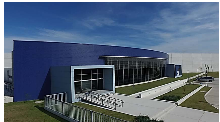
Ilustración 105. Data Center I Edificio de clientes y de servicios. Cada envolvente asume la actividad que contiene. Fotografía extraída de página web de Antel
