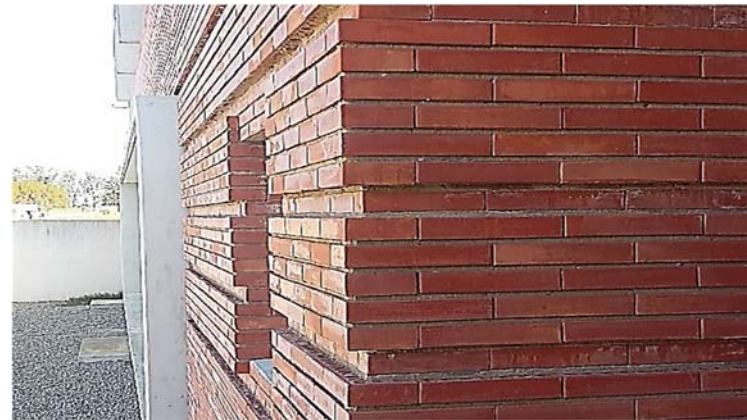
Ilustración 162. Instituto de Producción Animal | Detalle de buña y aparejo en ladrillo visto. Fotografía de autor.
