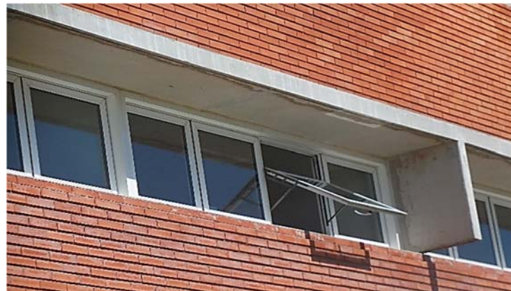
Ilustración 139. Instituto de Producción Animal | Fachada norte. Detalle de ladrillo y parasol de hormigón visto. Fotografía de autor.
