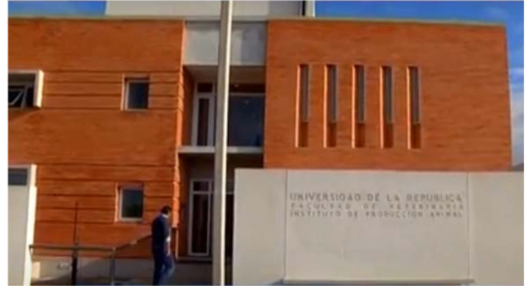
Ilustración 123. Instituto de Producción Animal | Terminación discontinua de envoltente con mampuestos cerámicos. Fotografía gentileza Arq. Daniel Calzada.
