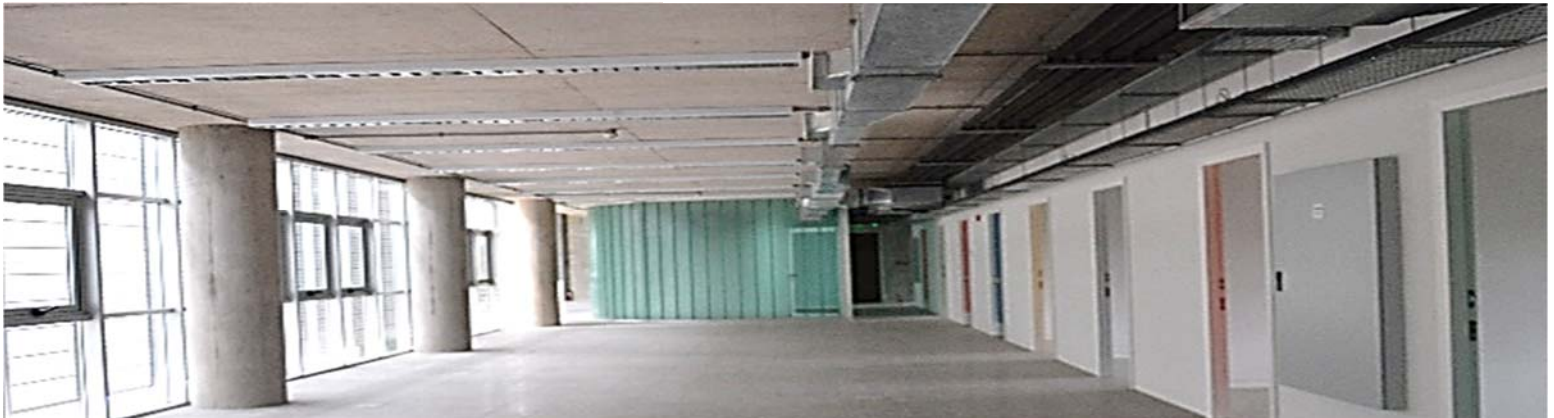
Ilustración 279. Centro Parque Batlle | Planta libre: terminaciones de superficies reflejantes del sonido (hormigón visto y vidrio). Fotografía de autor.
