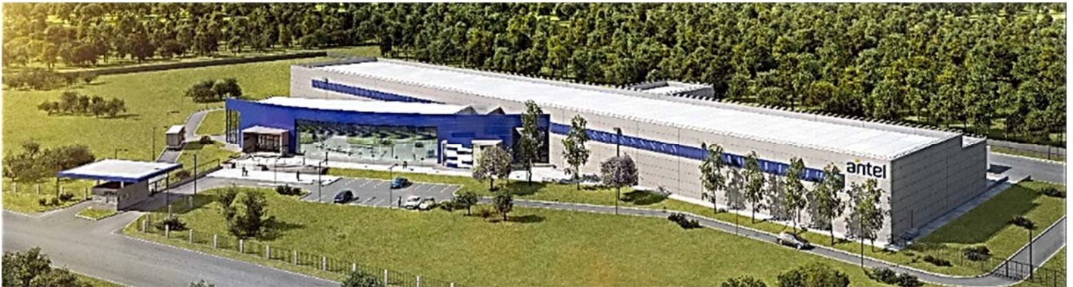
Ilustración 106. Data Center | Área edificada: 12 500 m 2 , en entorno de características rurales y próximo a Pando Fotografía extraída de página web de Ciensa
