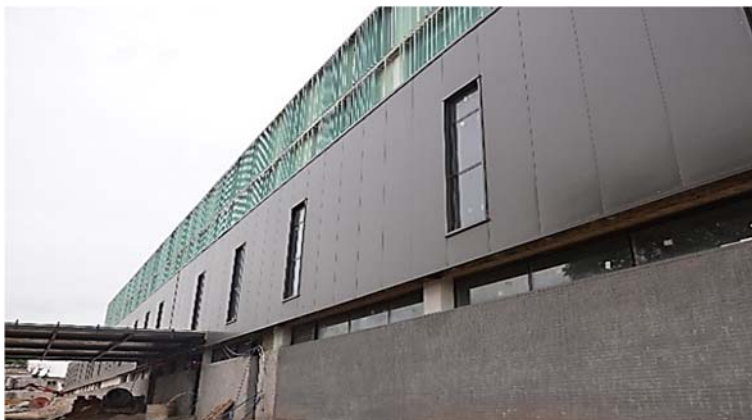
Ilustración 133. Sanatorio Banco de Seguros del Estado | Ajuste entre paneles de fachada longitudinal Fotografía de autor
