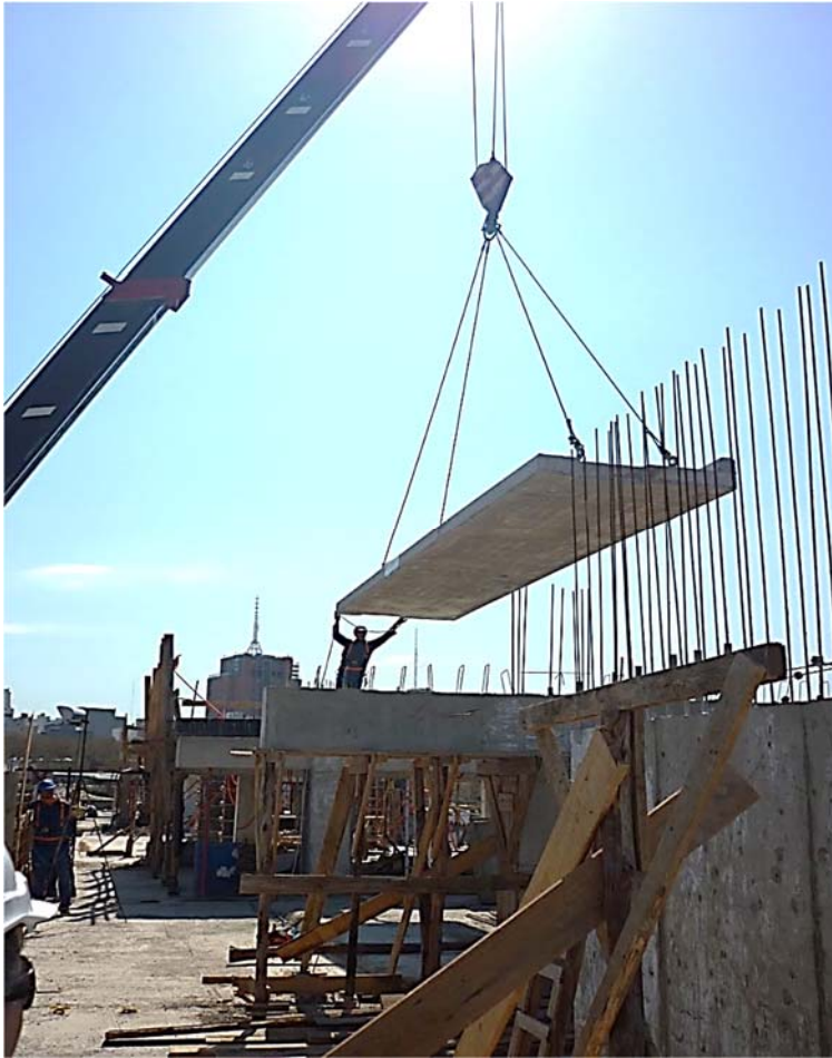
Ilustración 127. Covicordón | Montaje de loseta prefabricada coordinada modularmente con el ancho de la vivienda. Fotografía gentileza Unidad Permanente de Vivienda.
