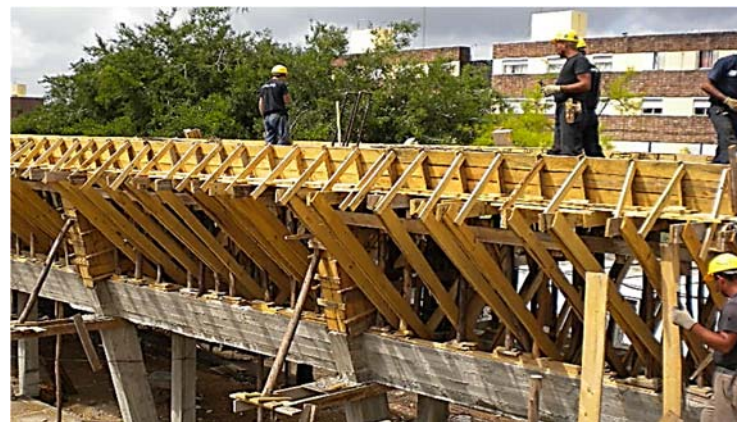
Ilustración 313. Escuela 296 Pando Sur | Canalón de importantes dimensiones facilita acceso para mantenimiento. Fotografía gentileza PAEPU.
