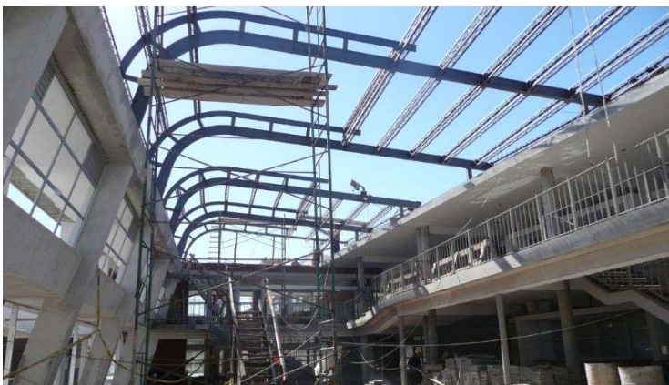
Ilustración 276. Escuela 296 Pando Sur I Trabajos en estructura cubierta previo al cierre con chapa prepintada. Fotografía gentileza Arq. Virginia Gallardo.
