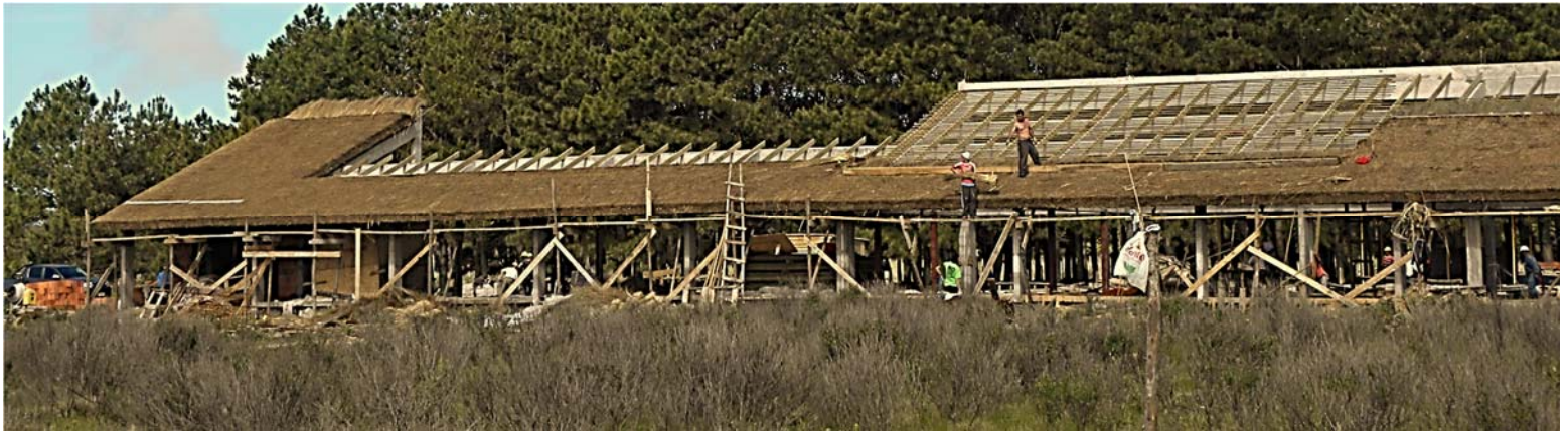
Ilustración 126. Portal del Polonio | Cierre de la cubierta con sistema tradicional de quincha. Fotografía gentileza Arq. Federico Gastambide.
