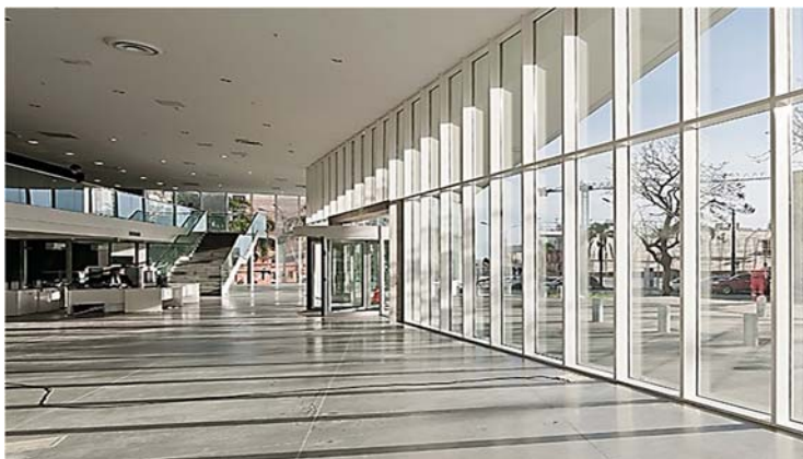
Ilustración 144. Anexo Torre Ejecutiva. Desarrollo cerramiento vidriado continuo hall de acceso. Fotografía gentileza Arq. Javier Olascoaga.
