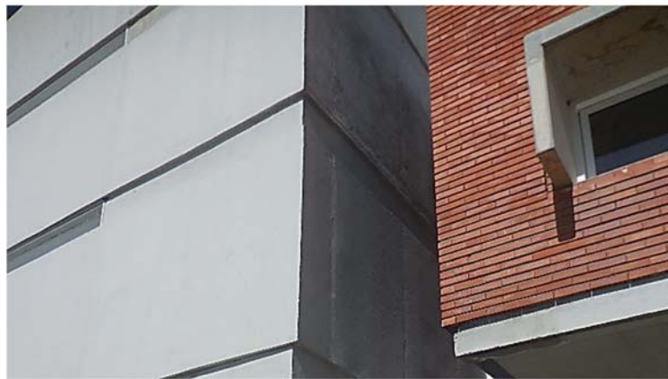
Ilustración 143. Instituto de Producción Animal | Detalle terminación continua en revoque predosificado monocapa. Fotografía de autor.
