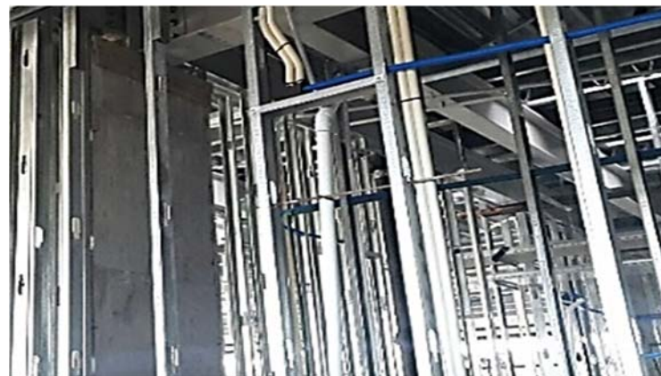
Ilustración 290. Sanatorio Banco de Seguros del Estado | Instalaciones coincidentes en plomo con hoja interior liviana. Fotografía de autor.
