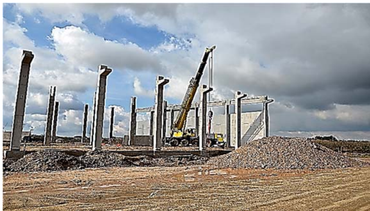
Ilustración 183. Data Center I Edificio de servicios. Montaje de prefabricados de conformación de la envoltente. Fotografía gentileza Arq. Carlos Rodríguez.
