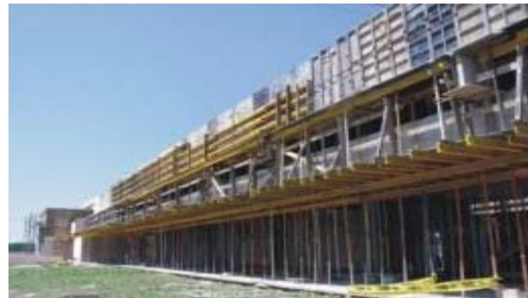
Ilustración 266. Instituto de Producción Animal | Fachada norte - materialización. Fotografía gentileza Arq. Daniel Calzada.
