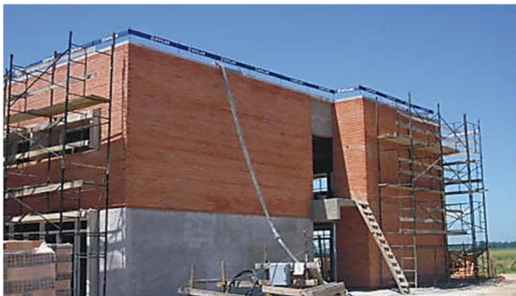
Ilustración 138. Instituto de Producción Animal | Fachada este. Revestimiento con ladrillo industrializado. Fotografía gentileza Arq. Daniel Calzada.
