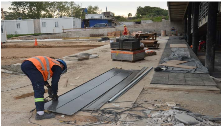
Ilustración 260. Sanatorio del Banco de Seguros del Estado | Estructura y fijación sistema de paneles. Fotografía de autor.
