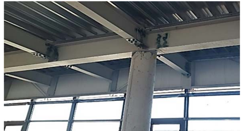
Ilustración 131. Hospital Banco de Seguros del Estado | Estructura metálica. Unión soldada de vigas y pilar de hormigón. Fotografía de autor.
