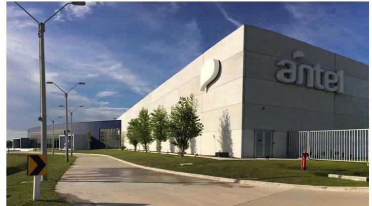
Ilustración 228. Data Center | Edificio de servicios. Álamos piramidales a lo largo de la fachada longitudinal. Fotografía extraída de página a web de Antel.
