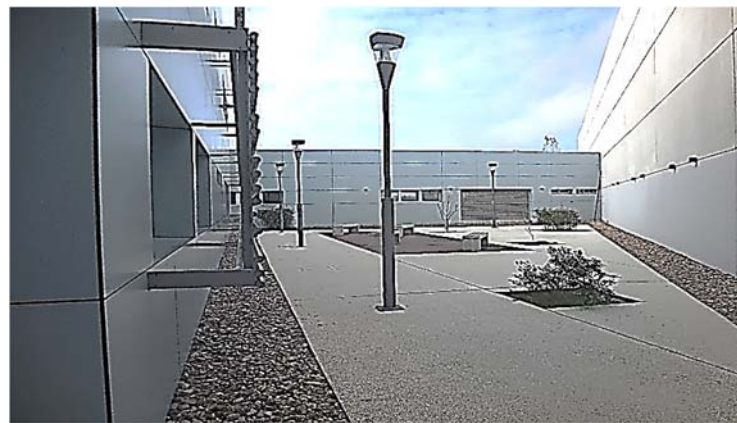
Ilustración 98. Data Center I Fachadas interiores - patios Fotografía de autor
