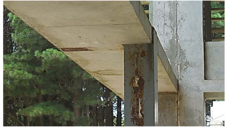
Ilustración 305. Portal del Polonio I Pilares metálicos: estado relevamiento 2020. Fotografía de autor.
