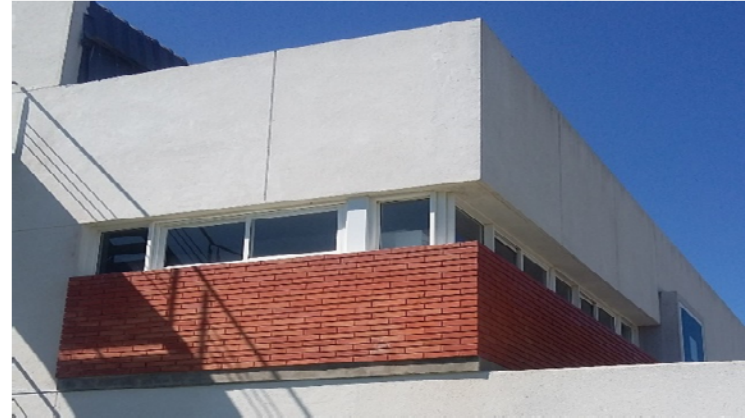
Ilustración 161. Instituto de Producción Animal | Terminaciones: antepechos en ladrillo visto, dinteles revocados. Fotografía de autor.
