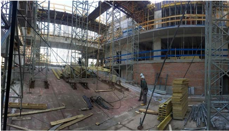
Ilustración 177. Anexo Torre Ejecutiva | Trabajos tradicionales de hormigón armado y mampostería. Andamios Fotografía gentileza Arq. Javier Olascoaga.
