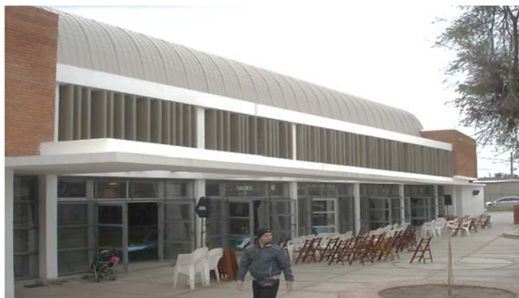
Ilustración 230. Escuela 296 Pando Sur | Alero sobre fachada oeste con enredadera hoja caduca - primer otoño. Fotografía gentileza PAEPU.
