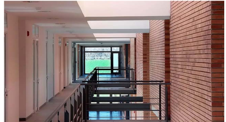
Ilustración 47. Instituto de Producción Animal | Estructura: sucesión de pórticos de hormigón y estructuras metálicas. Fotografía gentileza Arq. Daniel Calzada.
