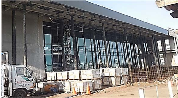
Ilustración 157. Sanatorio Banco de Seguros del Estado | Sistemas industrializados: estructura metálica .curtain wall. Fotografía de autor.
