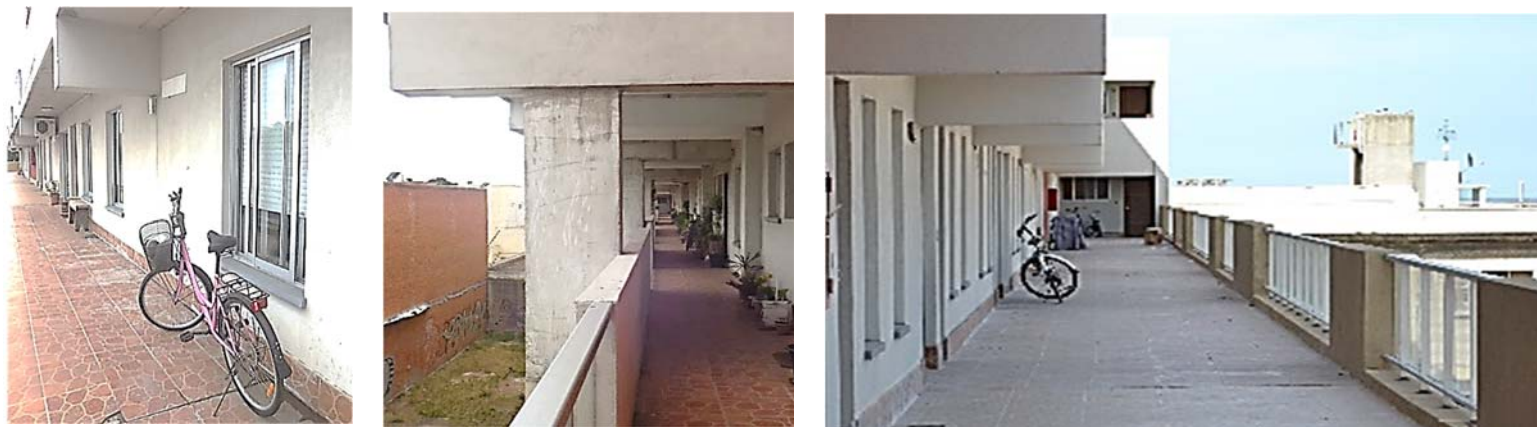
Ilustración 284. Covicordón | Articulación de la envolvente longitudinal mediante terrazas y calle corredor que permiten generar circulación cruzada de aire. Fotografías de autor.
