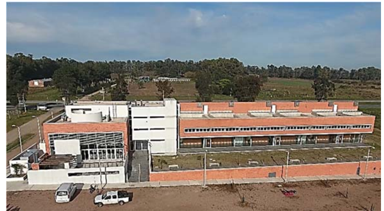
Ilustración 223. Instituto de Producción Animal | Fachada norte: extremo oeste - terraza de extensión de la cantina. Fotografía gentileza Arq. Daniel Calzada.
