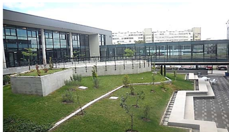
Ilustración 220. Sanatorio Banco de Seguros del Estado | Relación espacios colectivos de planta baja y jardines. Fotografía de autor.
