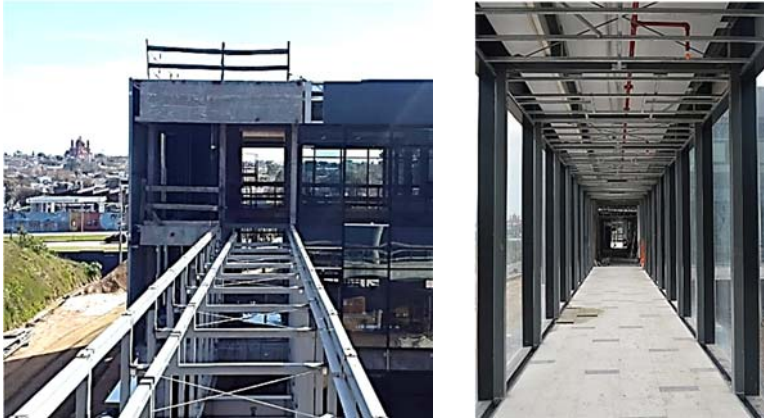
Ilustración 15 y 16 Sanatorio Banco de Seguros del Estado | Puentes conectores entre volúmenes: estructura y cierre. Fotografías de autor.
