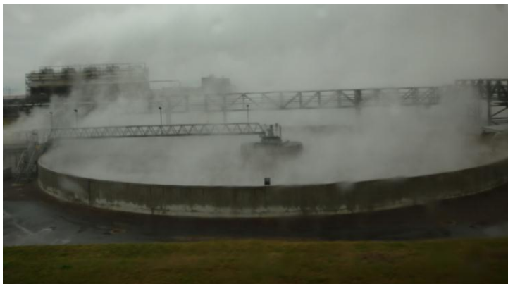
Fuente: Visita UPM - Pileta de fangos activados
