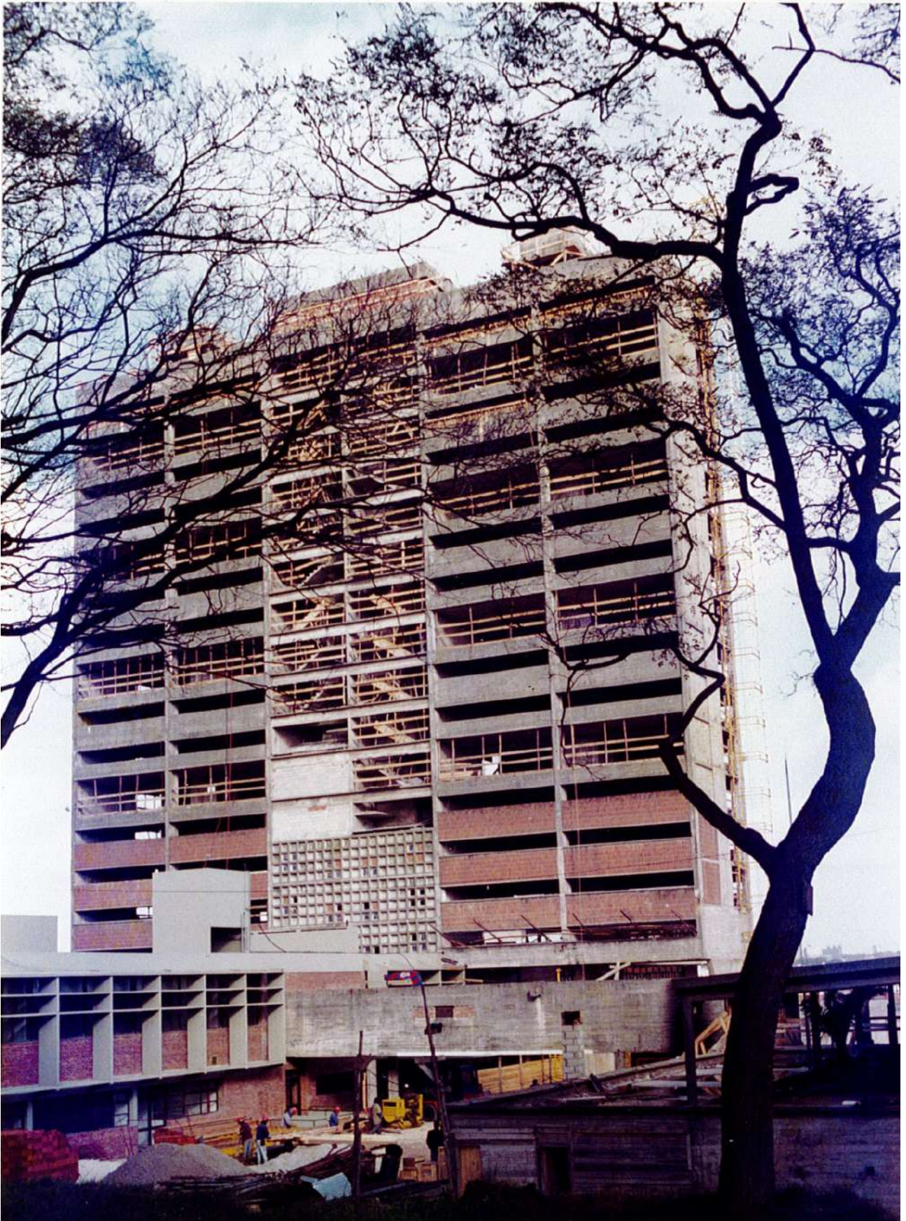
FIGURA 38 ▲ Fotografías de las obras de la etapa 1. Archivo DGA-UdelaR, escaneo.
