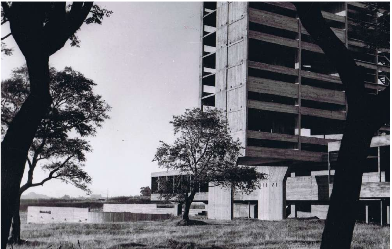
FIGURA 16 ▲ Vista parcial de la estructura. CDI, IHA.
