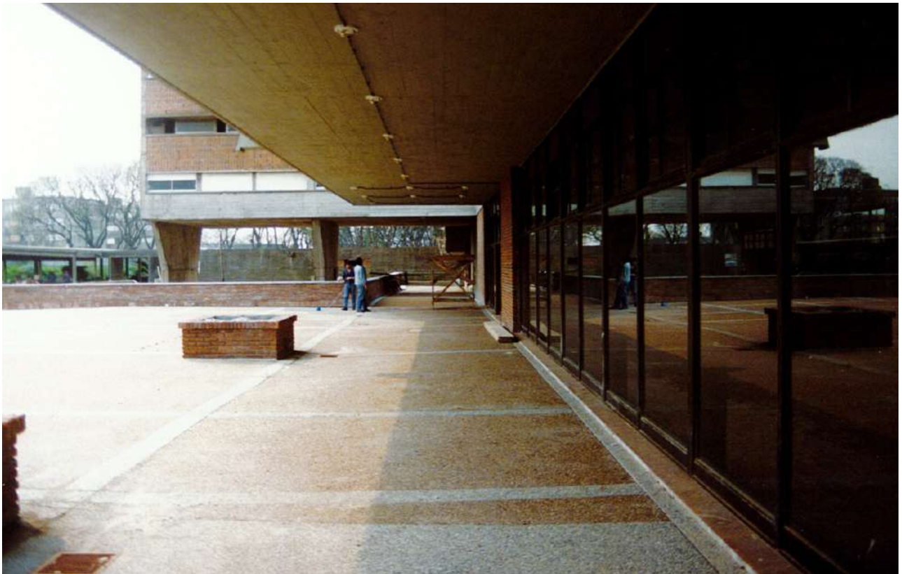
FIGURA 41 ▲ Fotografías del acceso Norte durante las obras de la etapa 1. Archivo DGA-UdelaR, escaneo.
