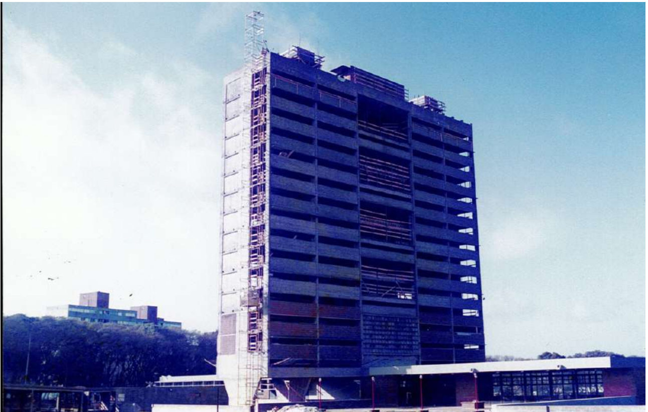
FIGURA 36 ▲ Fotografías de las obras de la etapa 1. Archivo DGA-UdelaR, escaneo.
