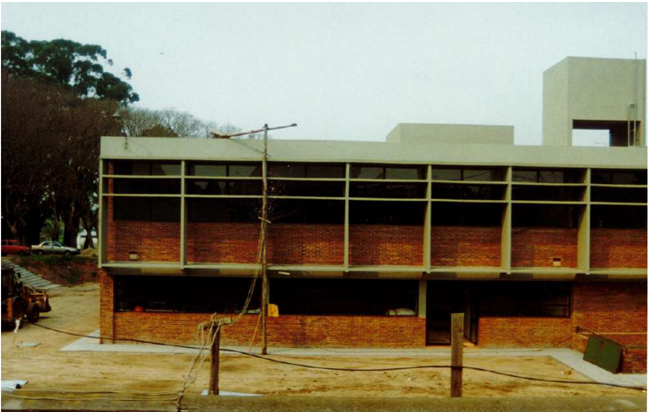
FIGURA 39 ▲ Fotografías de las obras de la etapa 1. Archivo DGA-UdelaR, escaneo.
