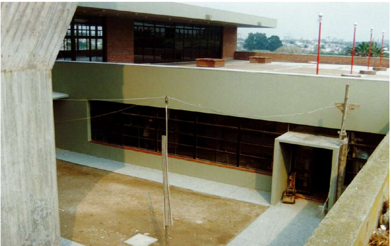
FIGURA 42 ▲ Fotografías de las obras de la etapa 1. Encuentro torre-basamento. Archivo DGA-UdelaR, escaneo.
