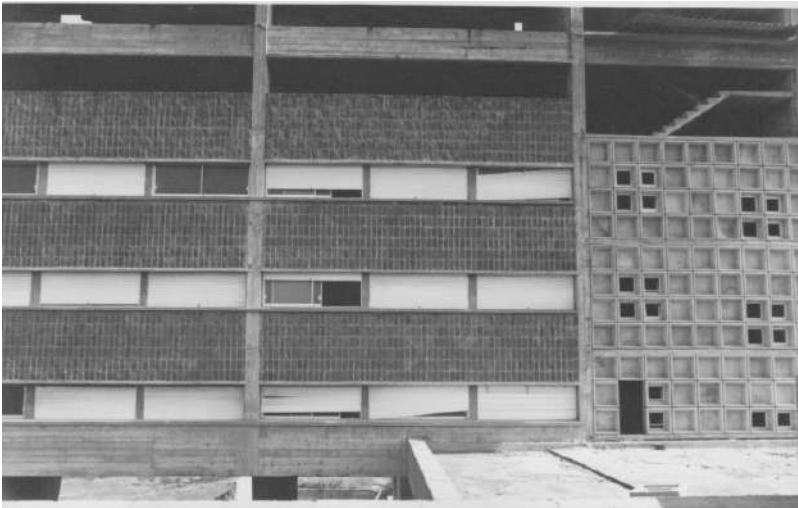
FIGURA 24 ◀ Vista parcial de fachada Este. Archivo DGA-UdelaR.
