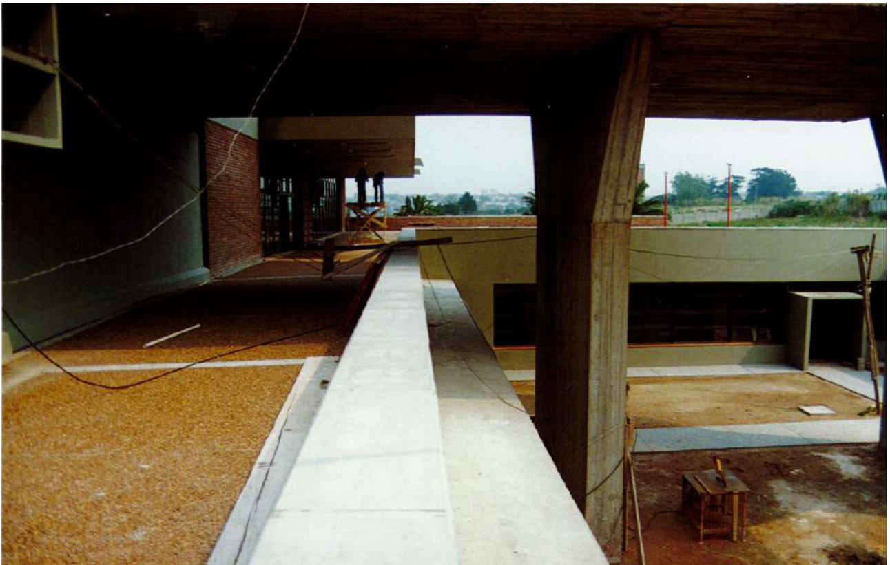
FIGURA 43 ▲ Fotografías de las obras de la etapa 1. Encuentro torre-basamento. Archivo DGA-UdelaR, escaneo.
