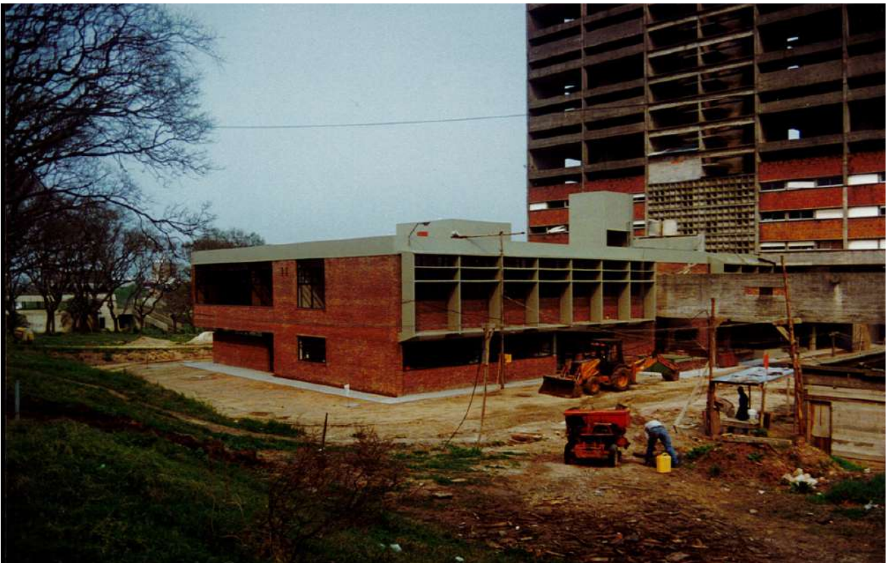
FIGURA 37 ▲ Fotografías de las obras de la etapa 1. Archivo DGA-UdelaR, escaneo.
