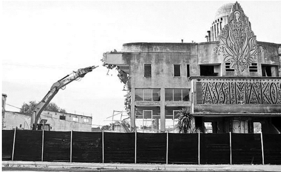
FIGURA 77. IMAGEN DEL EDIFICIO DE ASSIMAKOS DURANTE SU DEMOLICIÓN. FECHA: ENERO 2014. FUENTE: https://montevideoantiguo.net/index.php/ausentes/fabrica-assimakos.html
