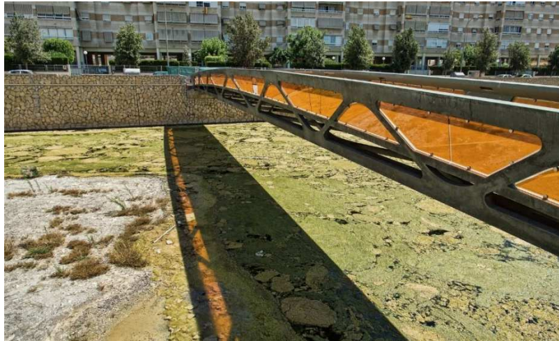
Figura 1-7. Pasarela peatonal sobre el Barranco de las Ovejas, Alicante.
