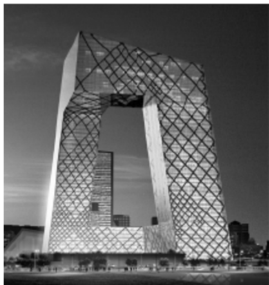
Figura 1-3. Torre de la CCTV, China.
