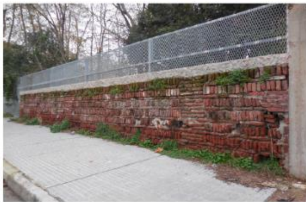
Fotos del muro tomadas en mayo de 2020, luego de las obras del nuevo Hospital Pasteur.
