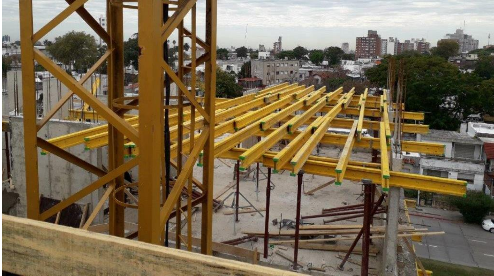
Figura 25. Construcción. Foto: OLAGÜE, Agustina. 2021.
