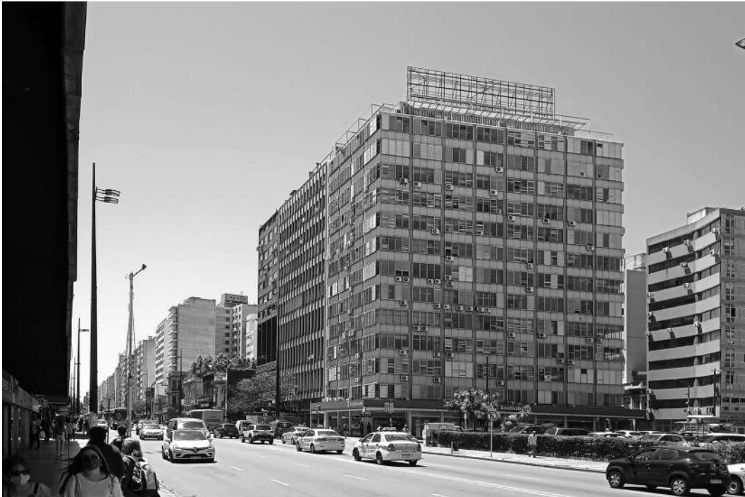
Figura 2.10: El BCLA y su entorno inmediato, octubre de 2021. Vista desde la acera norte, de oeste a este.
