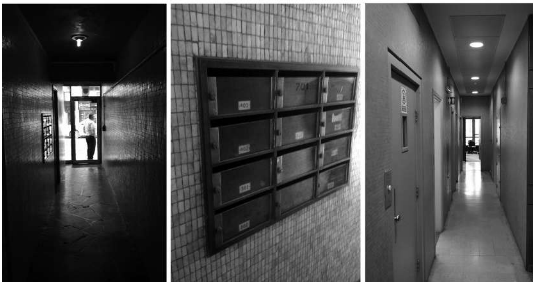
Figura 2.10: Pielés pétreas del BCLA: pastillas venecianas. Se aprecian los revestimientos en áreas de servicio, al oeste del núcleo, tanto interiores como exteriores. La disposición de este elemento, que es trabajado por planos, sigue y acentúa, sin embargo, la proporción y verticalidad de la composición de las fachadas.
