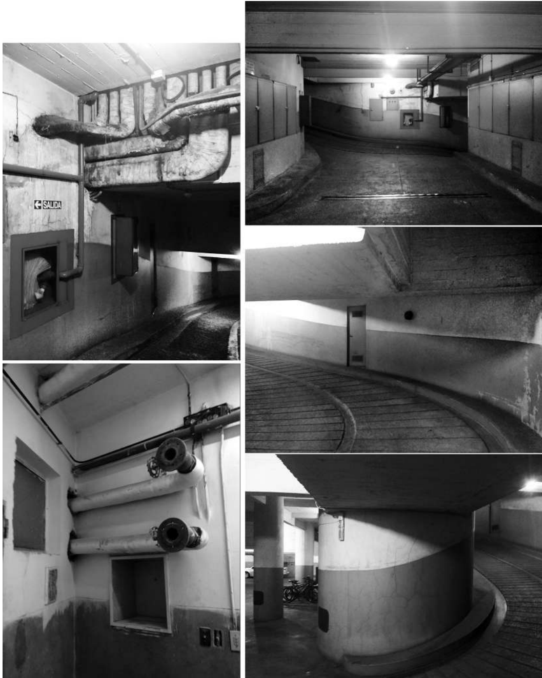
Figura 2.9: Subsuelos del BCLA con parte del sistema de circulación vehicular y de aguas corrientes. Se aprecian a la derecha las rampas llegando al primer subsuelo y al segundo, donde se altera la forma del núcleo estructural. También se aprecia el depósito del tesoro suspendido. A la izquierda: terminales y cañerías de incendio y agua caliente del sistema de calefacción de las viviendas.
