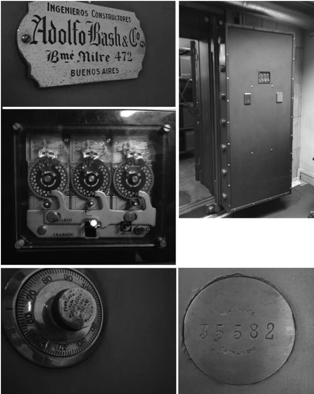
Figura 2.1: La bóveda del tesoro del Banco. Se aprecian en estado original los mecanismo de apertura de la puerta y el número de registro 35582. Instalada por Adolfo Bash y Compañía, ingenieros constructores de la ciudad de Buenos Aires.
