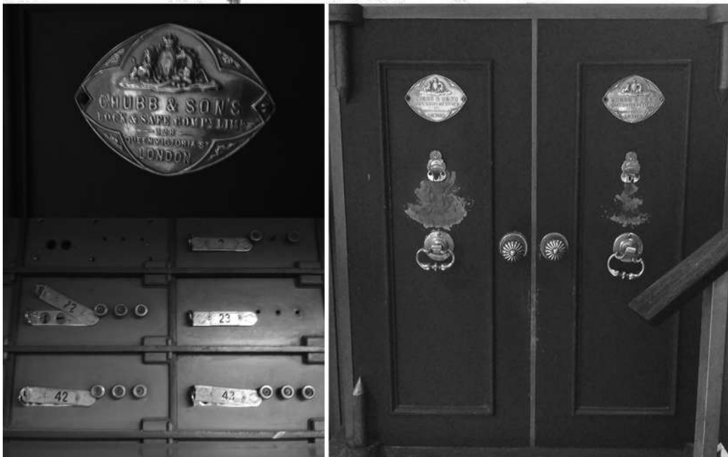
Figura 2.2: Vestigios del tesoro del Banco en el primer subsuelo. Se aprecian los cofres, la bóveda de papeles de origen inglés y la plaqueta de la escotilla de trasiego de dinero al garaje.
