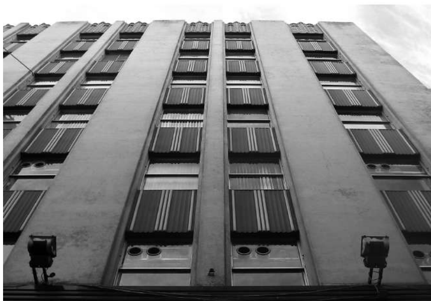
Figura 4.26: Alternativas del uso del spandrel en el Edificio Artigas, el Edificio del Notariado y el BCLA. Se aprecia la relevancia que asigna la presencia del mullion en la lectura independiente del muro cortina.
