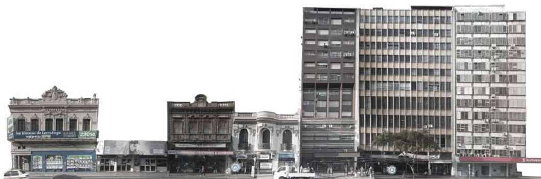
Figura 4.34: Situación actual de consolidación de la manzana del BCLA sobre la Avenida 18 de Julio.
