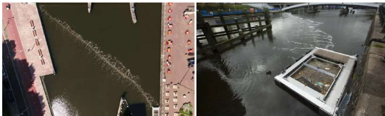
Figura 1.5: Barreras de burbujas colocadas por el grupo holandés TGGB en Holanda
