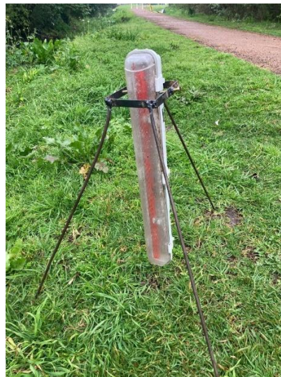
Figura 19: Limnógrafo instalado con trípode para los puntos AMO 0 y AMO 0-1.
