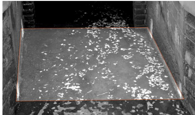
Figura 15: Ejemplo de procesamiento del video registrado el 24/04/2022 en el punto MO 1. Se pueden ver la RdI delimitada (en rojo), los chips de madera sembrados sobre la superficie del agua y los cuatro puntos de referencia pintados en blanco sobre las paredes del canal.
