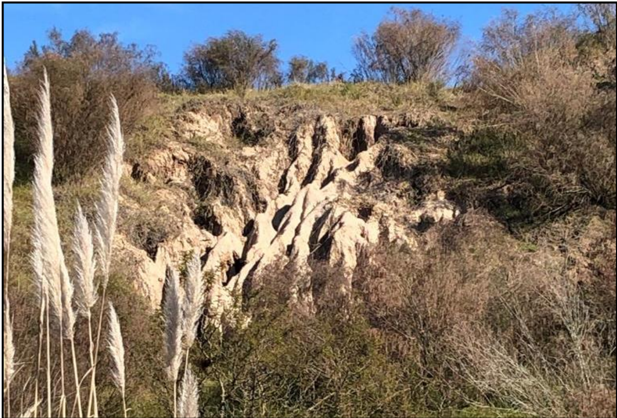
Figura 17. a. Proceso erosivo sobre al margen de alcantarilla de desagüe existente. b. Talud de cantera Perez Bustos, erosionada.
