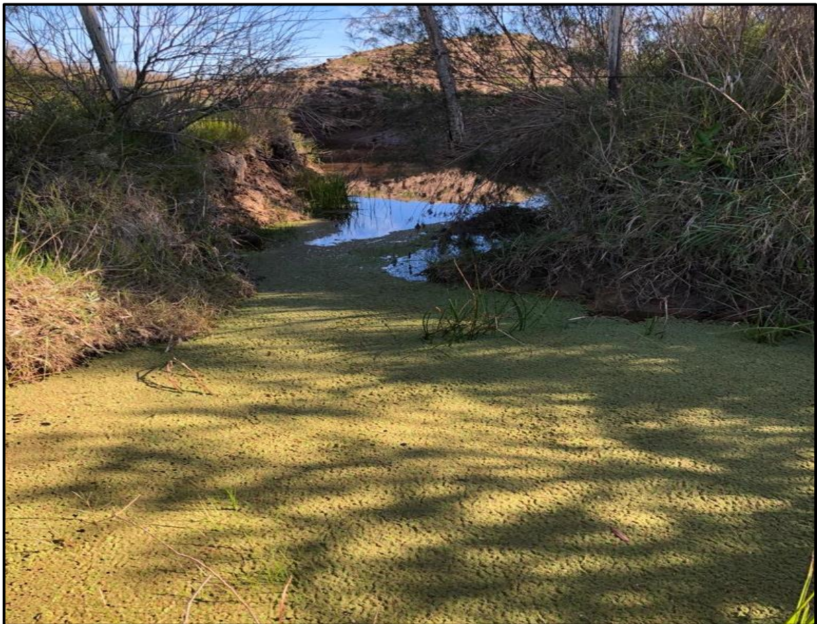
Figura 19. Canalización de pluviales que recoge el frente de explotación de la cantera H. Martínez, un emprendimiento de carácter privado que deriva sus aguas a una alcantarilla en camino vecinal, la cual está obstruida por gran cantidad de sólidos. Puede apreciarse la eutrofización del agua, generando una especie de lago léntico.
