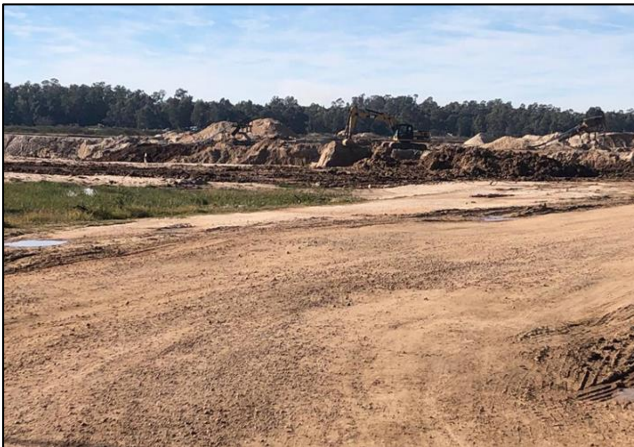
Figura 14. Retroexcavadora sobre bandas extrayendo arena y acopiando
