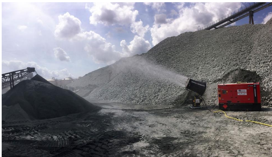
Figura 3-40. Cañón nebulizador rociando el penacho de una planta de procesamiento de áridos en una cantera (extraído de https://www.interempresas.net/ObrasPublicas/Articulos/246396-Como-reducir-el-polvo-generado-en-las-canteras.html ).
