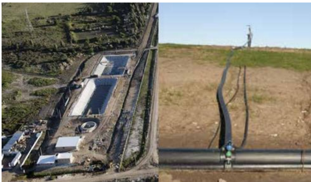
Figura 3-5. Planta de tratamiento de lixiviados (izq.) y sistema de recolección de biogás (der.) del relleno sanitario de Felipe Cardoso (extraído de Bajsá, 2020).
