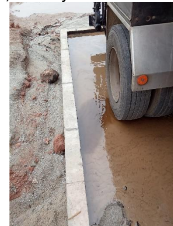
Figura 4 – Aguas pluviales contenidas por la cordoneta en sitio de estacionamiento de camiones.
