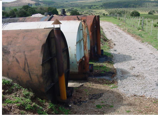
Figura 3 – Tanques con contención lateral del terreno sin asegurar la estanqueidad (1).
