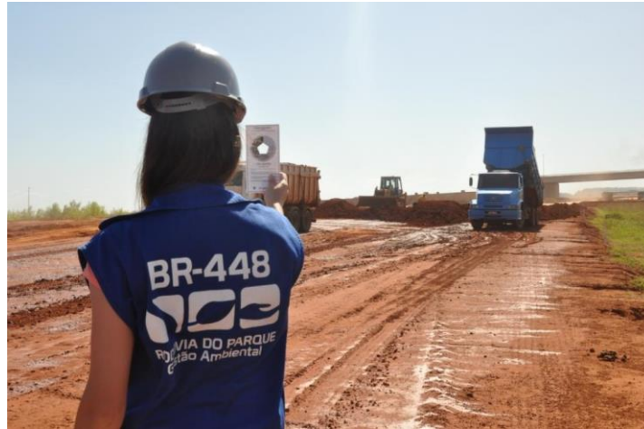
Figura 3-37. Operadora utilizando la escala de Ringelmann para medir humos de escape de camiones en obras de pavimentación de carreteras (extraído de https://es.wikipedia.org/wiki/Escala_de_Ringelmann ).
