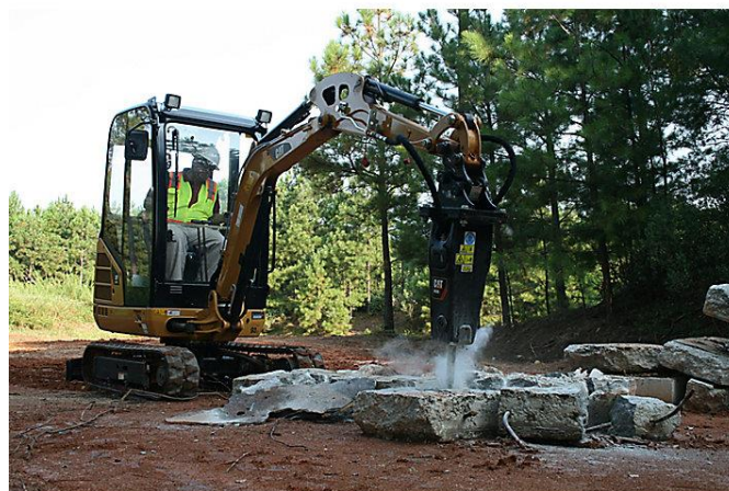
Figura 3-13. Martillo hidráulico montado sobre retroexcavadora fragmentando restos de hormigón armado (extraído de www.cat.com ).
