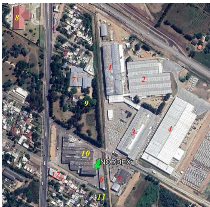
Figura 10.11. Identificación de obstáculos que pueden afectar el flujo de viento alrededor del emplazamiento, enumerados del 1 al 12. Adaptado mapa Google Earth
