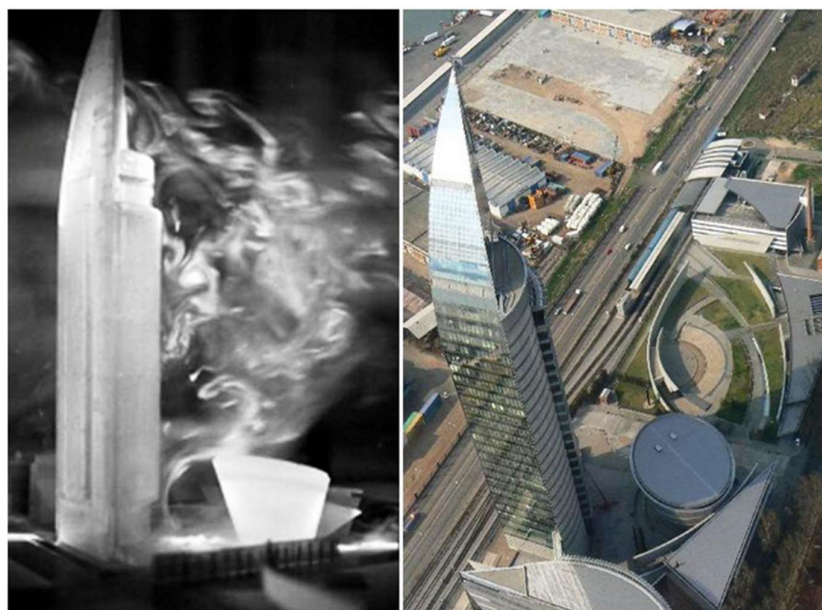
Figura 9.21. Ejemplo de aplicación de técnicas de visualización de flujo alrededor de la Torre Antel en Montevideo, Uruguay, en el túnel de viento del IMFIA, Udelar.
