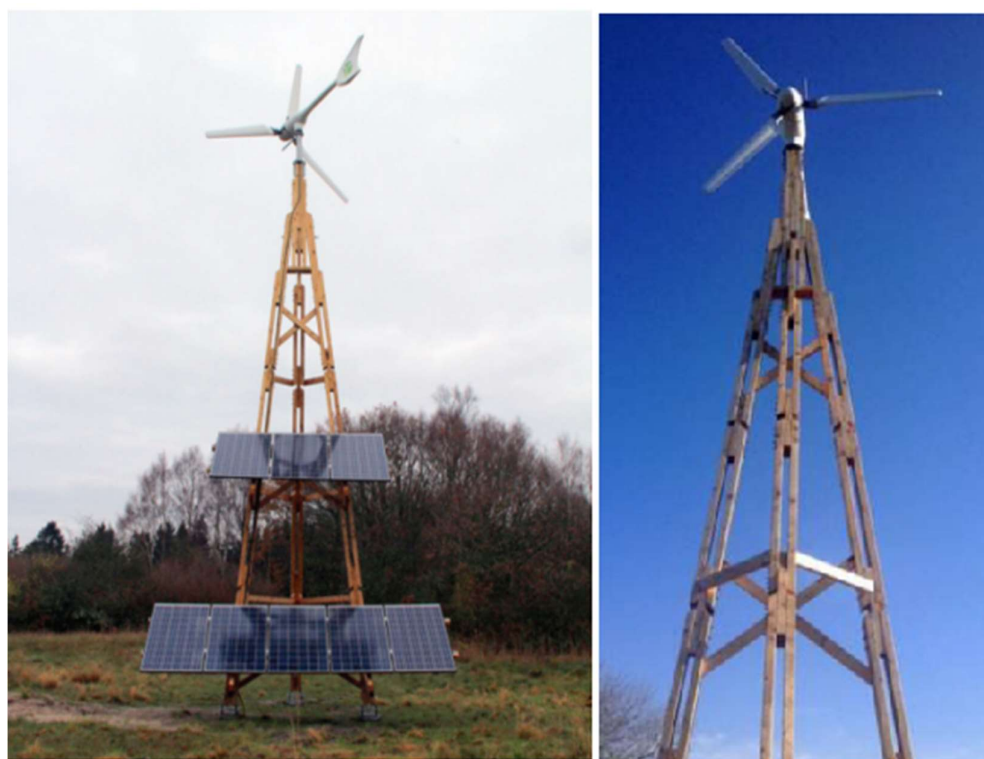
Figura 3.37 Torres en trípode de madera para la instalación de pequeños aerogeneradores y de paneles solares fotovoltaicos 26
