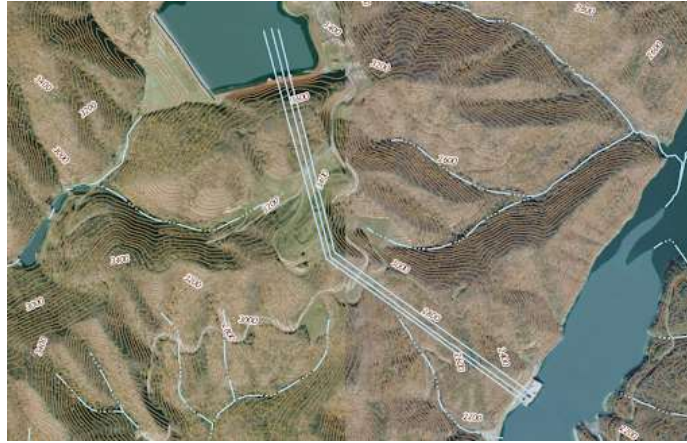
Ilustración 46-Central de Acumulación de Bath County (Virginia, EEUU)
