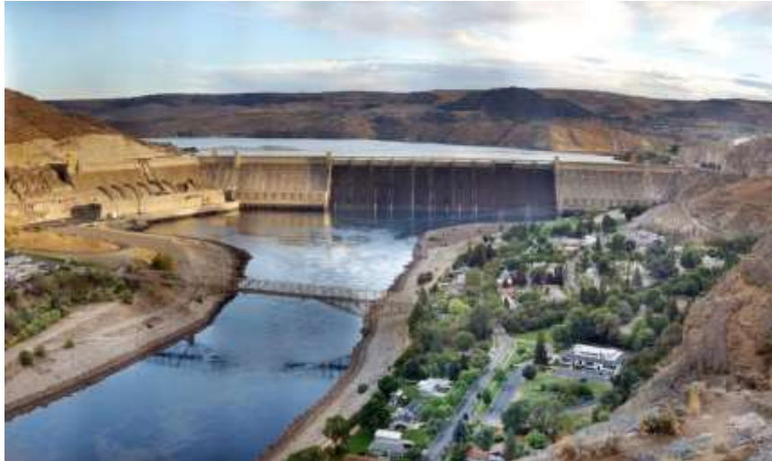
Ilustración 48-Central de generación hidroeléctrica Grand Coulee Dam (Washington, EEUU)
