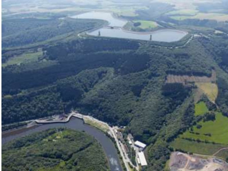
Ilustración 45-Central de Vianden, Luxemburgo
