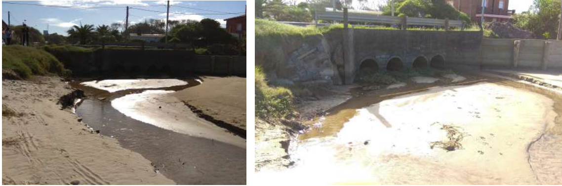
Figura 8: Situación de la cañada en el tramo 2
