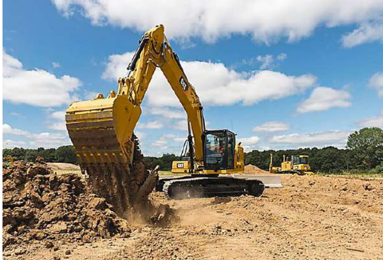
Figura 84: Retroexcavadora sobre orugas Caterpillar 320
