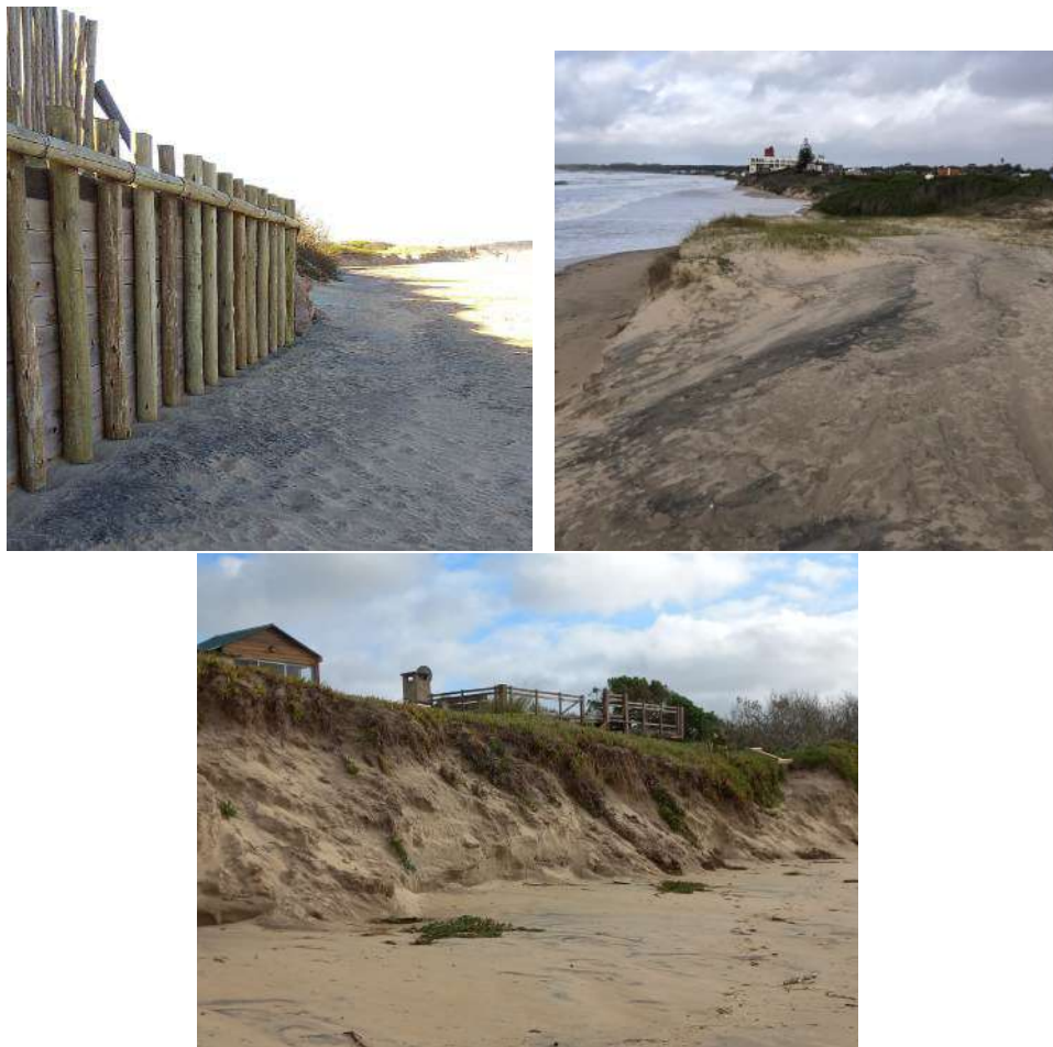
Figura 5: Situación del tramo 1
