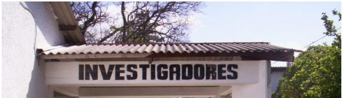
Fotografía 2. Fachada de uno de los pabellones del edificio escolar.
