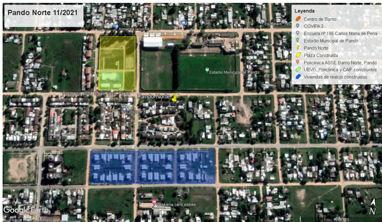
Imagen 27: Imagen satelital Pando Norte con avance importante de obras culminadas a noviembre 2021
