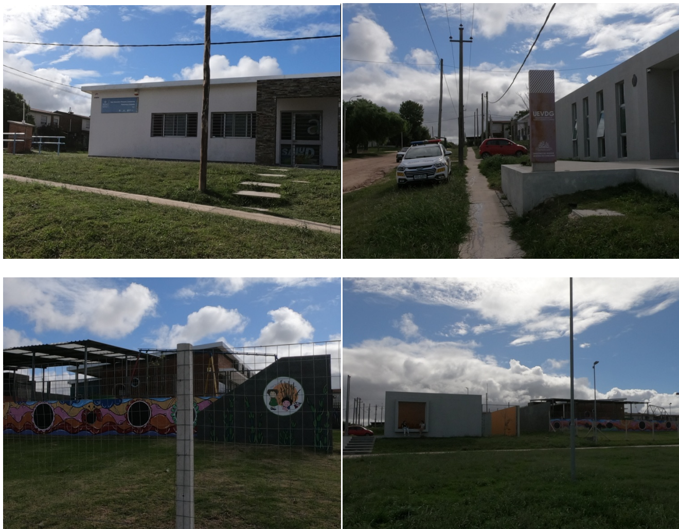
Imagen 37: Conjunto de fotografías de obras construidas por el PMB de Policlínica, Unidad Especializada en Violencia Doméstica y Centro CAIF
