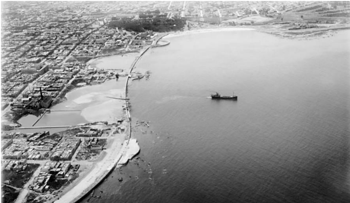
Ilustración 17: Rambla Sur Vista aérea de las playas de Patricio y Santa Ana durante las obras de drenaje y relleno para la construcción de la Rambla Sur. Año 1930 (Fuente: CMdF - 174FMHE)
