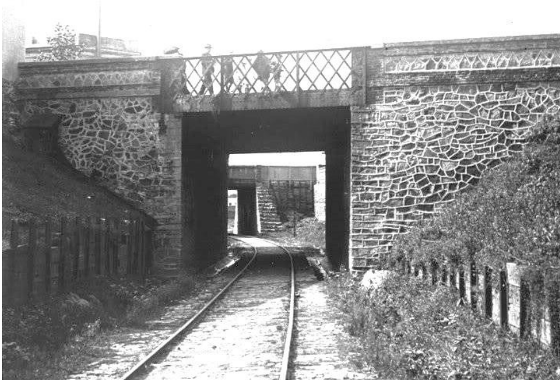
Ilustración 32: La trinchera para el Ferrocarril Uruguayo del Este
