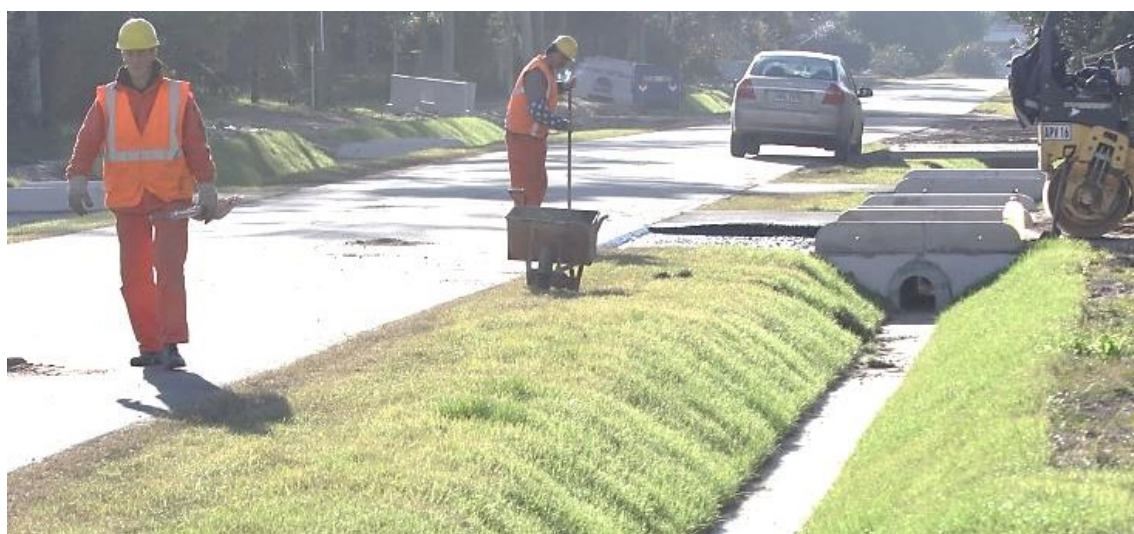
Ilustración 58: Cunetas previstas para laminación, terminadas (Fuente: www.imcanelones.gub.uy )
