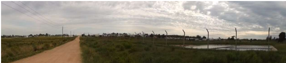
CALLE Y PLANTA DE TRATAMIENTO EN LOS DOS CNVM EN SAN JACINTO
