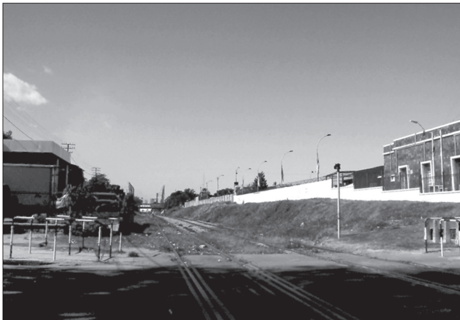
Figura 7. Vía del ferrocarril en el cruce con la calle Capurro.
