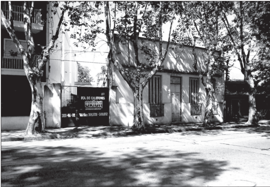
Figura 23. Vivienda estándar, actualmente destinada a fábrica.
