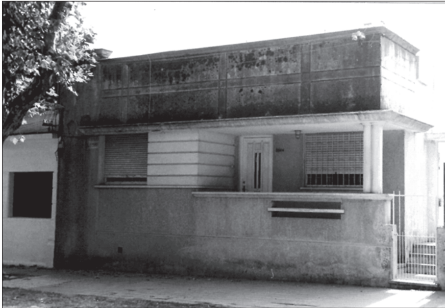
Figura 29. Vivienda de los años cuarenta aproximadamente (actualmente su fachada presenta regular estado de conservación por falta de mantenimiento).
