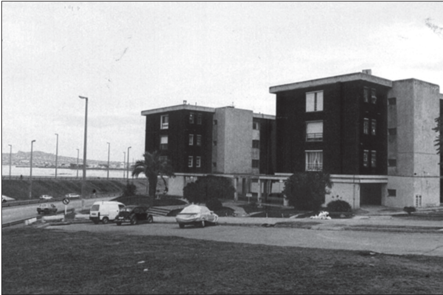
Figura 40. Conjunto habitacional realizado por la IMM en la calle Gil, ubicado originalmente frente a espacio ajardinado frente a la rambla, que fue excavado y terraplenado para construcción de los accesos de ruta 1 a Montevideo.
