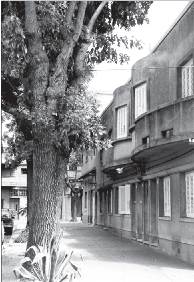
Figura 25. Conjunto de viviendas. Foto: Alberto Marcovecchio, 2000
