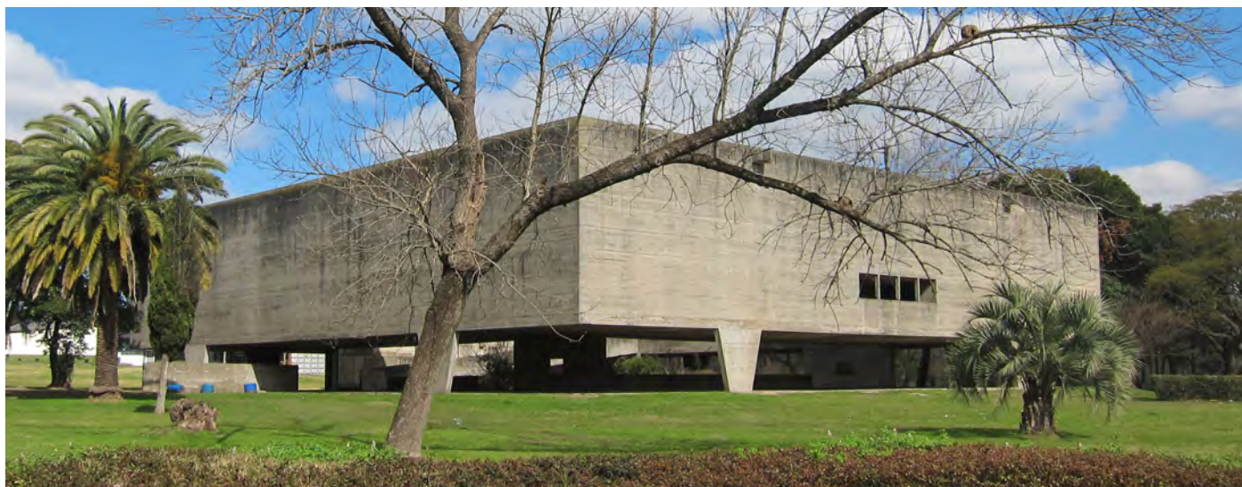
1. Vista de las fachadas este y norte / View of the east and north facades
