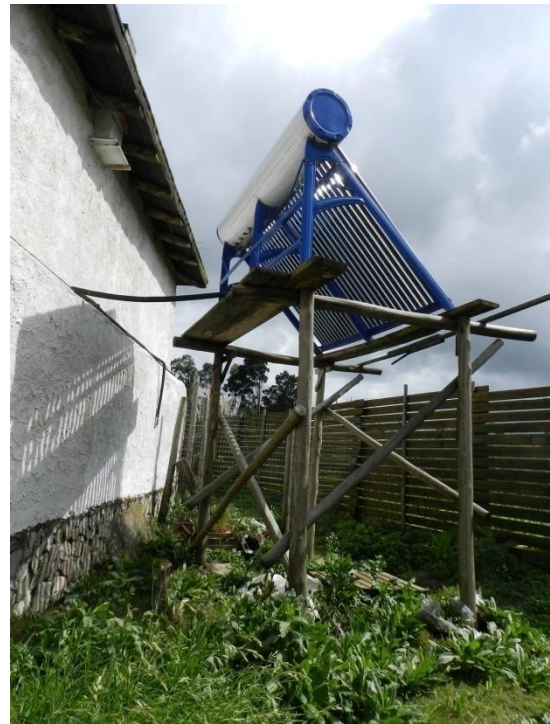
Sistema de colectores, se coloca un colector que abastece a dos viviendas. Cinco colectores en total.
