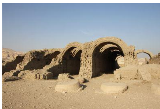
Bóvedas del templo mortuario de Ramases II, construido con adobes hace mas de 3000 años en Gournah, Egipto.
