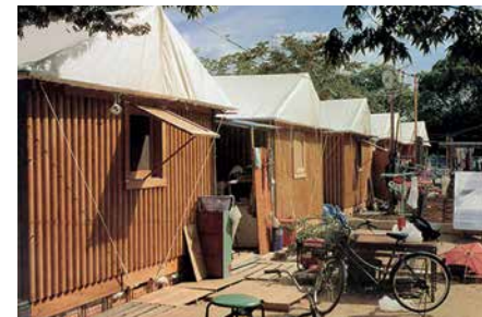
Imagen 26. Refugios de tubos de papel en Kobe, Japón. Shigeru Ban Architects, 1995 Fuente: www.shigerubanarchitects.com
