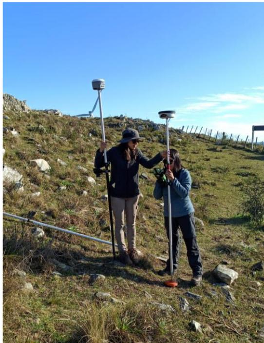
*Ilustración 6.11: Relevamiento con GNSS del perfil de nivelación.*
