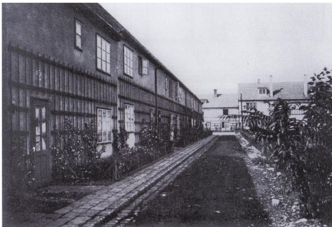
Josef Frank: Siedlung Hoffingergasse (Viena, 1920-21). Vista general. Blau, 116
