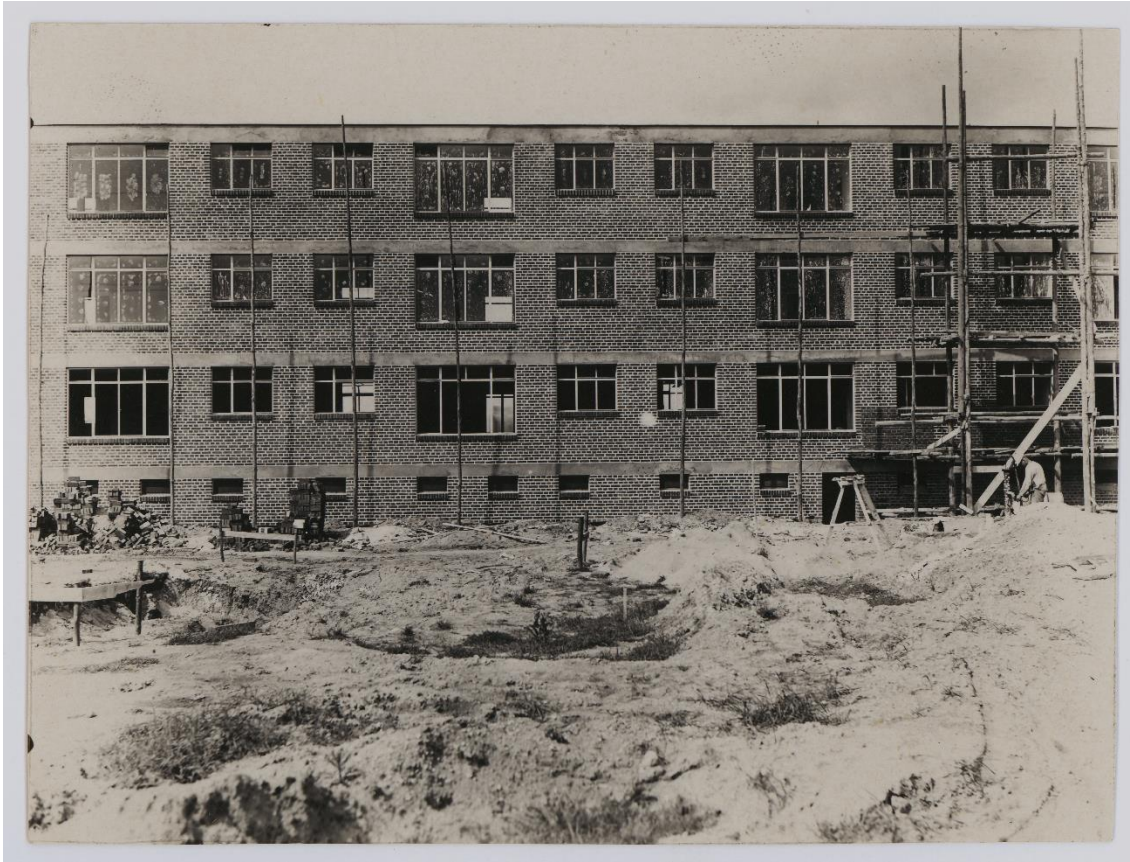
Laubenganghäuser en construcción, fachada sur (1929-1930). Foto: Helmut Schulze (?). Bauhaus-Archiv Berlin. Inv. n° 12635/64.
