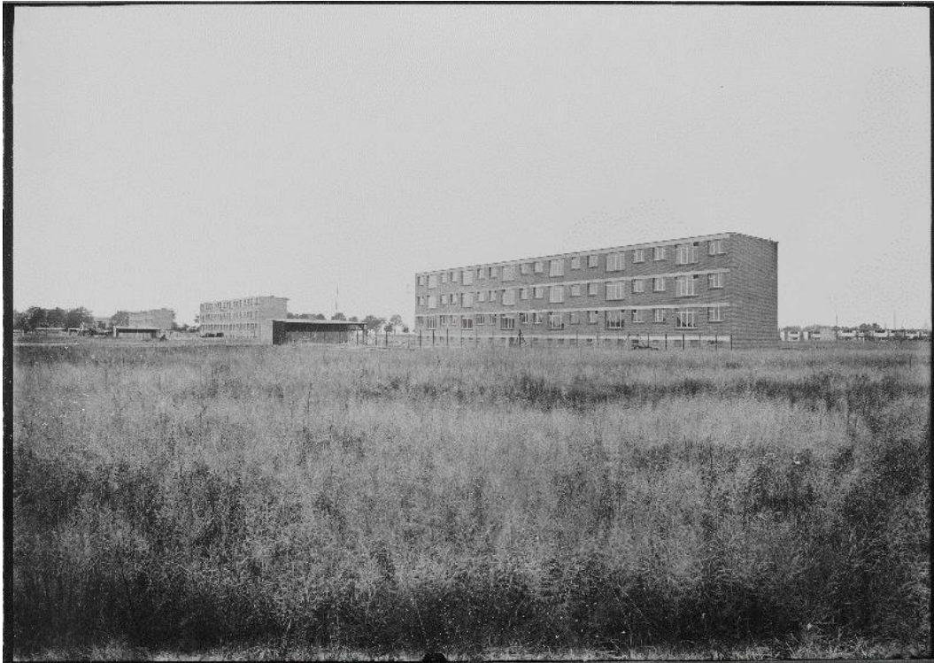
Laubenganghäuser, vista sureste.
