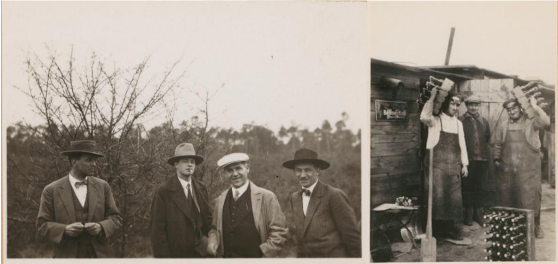
Izq: Hans Wittwer, Thomas Flake, Hannes Meyer y Hermann Bunzel en el entorno de la escuela de la ADGB. Foto: Erich Consemmüller (1928-1929). Der: La escuela de la ADGB en construcción: albañiles en el obrador. Foto: Hermann Bunzel (1928-1929). Bauhaus-Archiv Berlin. Inv. n° 9186-3 y 9190-16.
