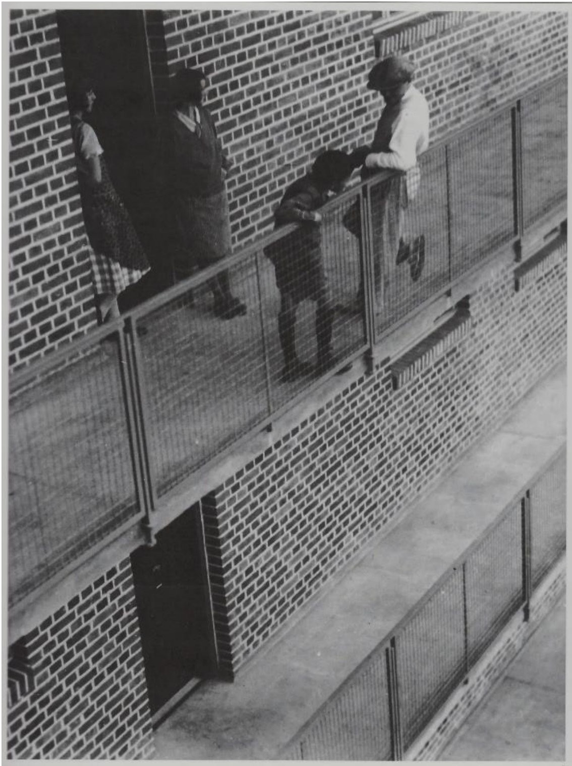
Laubenganghäuser (1929-1930). Vista parcial de la fachada norte. Kleinerüschkamp, 232.
