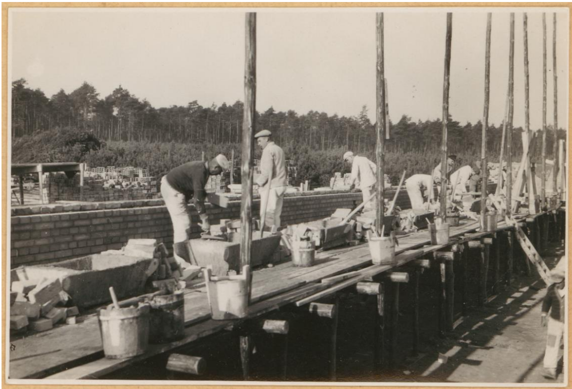
La escuela de la ADGB en construcción, levantamiento del sótano (1928-1929). Bauhaus-Archiv Berlin. Inv. n° 9190/73.
