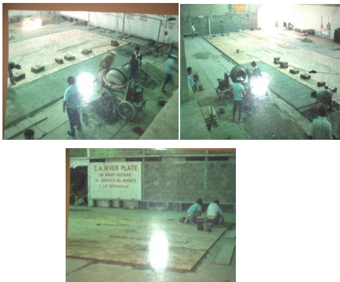
Figura 21 – Fotografías referentes a la colocación del piso del gimnasio
