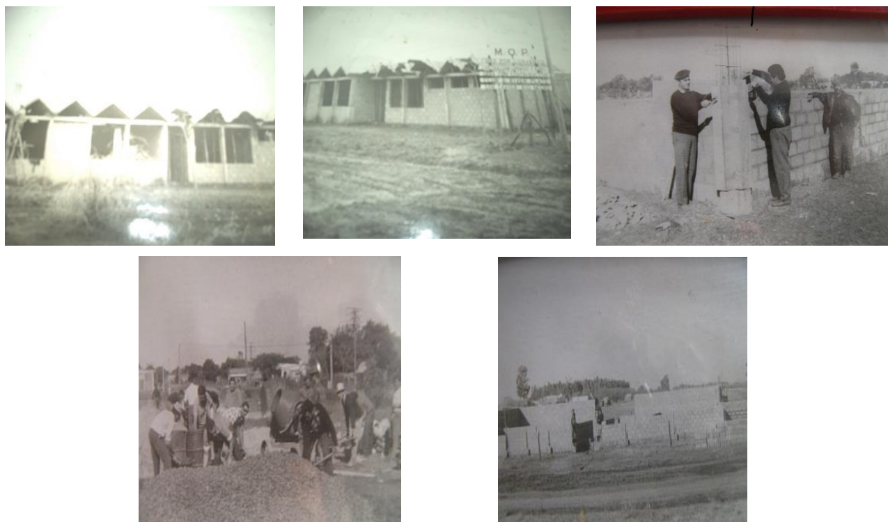
Figura 6 – Fotografías referentes a la construcción de la nueva sede social
