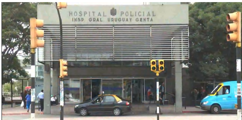
Imagen 18: Fachada del Hospital Policial. Fuente: Tomado de video "Ahorro energético en el Hospital Policial".
