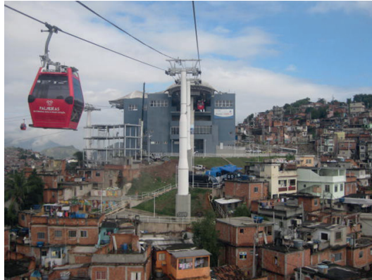
Figura 2. Metrocable Río de Janeiro, Complejo del Alemán
