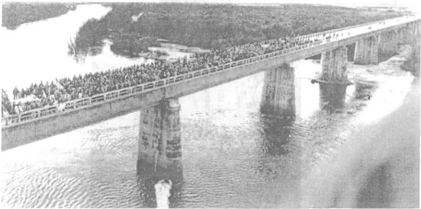
- Puente sobre el Arroyo Rocha en Ruta 9.
