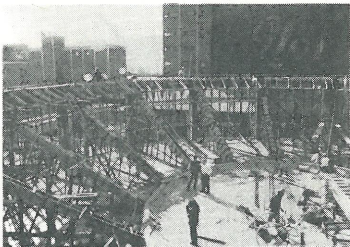
Foto N° 8.- Colocación de encofrados de cables v anillo superior de compresión.
