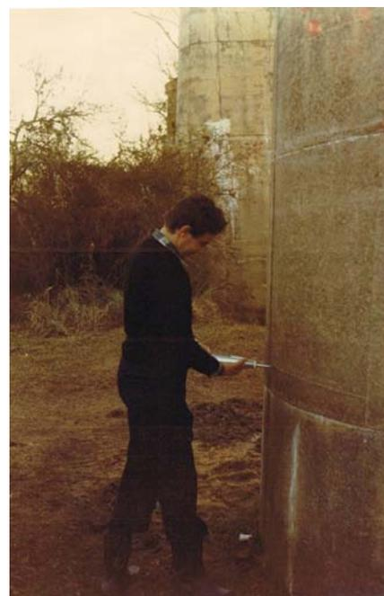
El estado de las pilas era bueno, pero a muchas de ellas hubo que realizarles un refuerzo con cables verticales de postensado para eliminarles tracciones que se provocarían – en el futuro puente terminado – por esfuerzos horizontales de frenado, viento longitudinal, temperatura, etc.
