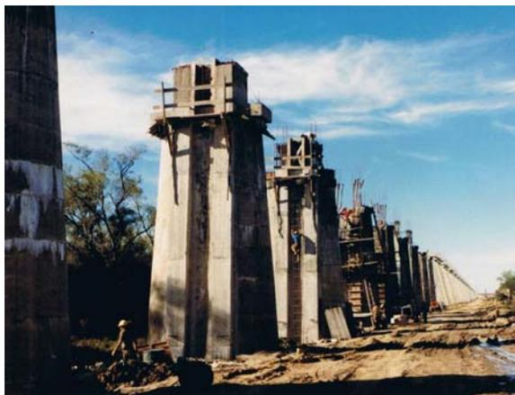
También a las pilas estribos fue necesario “anclarlas” hacia atrás con cables unidos a una placa de anclaje de hormigón, enterrada bajo el terraplén de acceso y luego, a medida que se construía el terraplén de acceso fueron tensados los cables.
