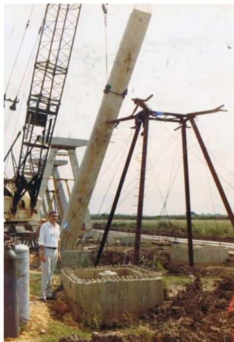
De esa manera sencilla se colocaron en sitio los pilares, los cuales tienen su armadura longitudinal sobresaliendo en la parte superior, para permitir la unión de todos los pilares de una pila (cuatro o dos, según la forma de cada pila) con el cabezal superior que cuenta con dos orificios con armaduras cruzadas en su zona media.
