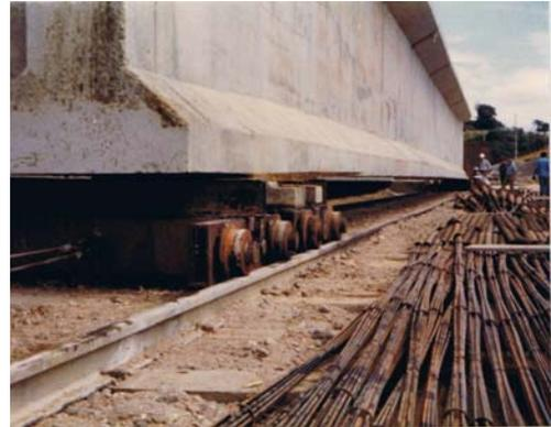
Luego el transporte y colocación de vigas por medio de una viga de lanzamiento de 90mts. de largo, que se fue apoyando sobre pórticos auxiliares (llamados binarios) que se van colocando sobre las pilas para pasarlas a un nivel superior al de las vigas ya colocadas y poder transportar las que están más allá de las ya ubicadas.
