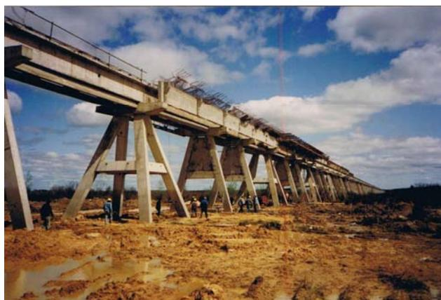
Luego de construidas, se levantaron y se colocaron, desplazándolas lateralmente, sobre las ménsulas de los cabezales de las pilas.
