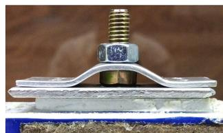
(b) Omega con tornillo de conexión y suplemento sobre el borne sin atornillar.
