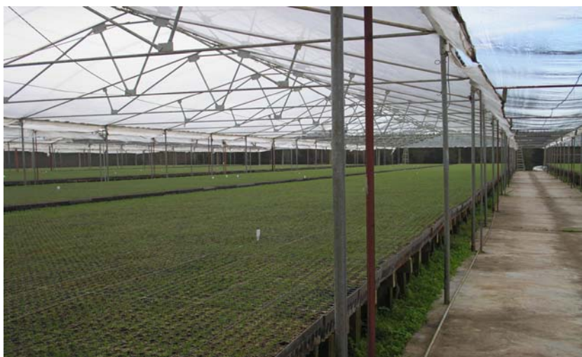
Figura 3: Foto del interior del invernáculo
